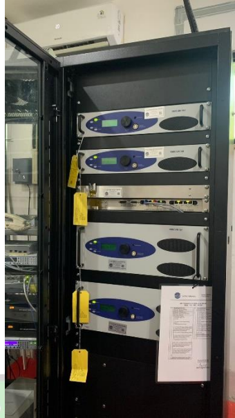
Gambar 3.11 Peralatan VHF-ER Upper Ambon Sumber: Dokumentasi Penulis, 2023
