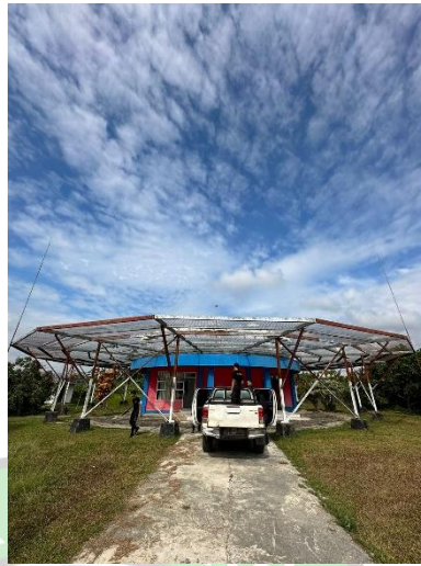
Gambar 3.13 Antena DVOR di Shelter DVOR Sumber: Dokumentasi Penulis, 2023
