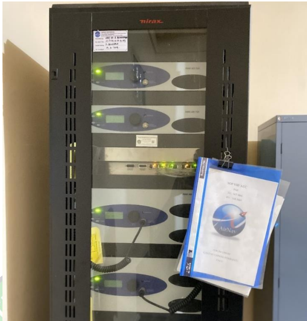
Gambar 3.8 Transmitter dan Receiver VHF ER A/G ACC MATSC Sumber : Dokumentasi penulis 27 November 2023
