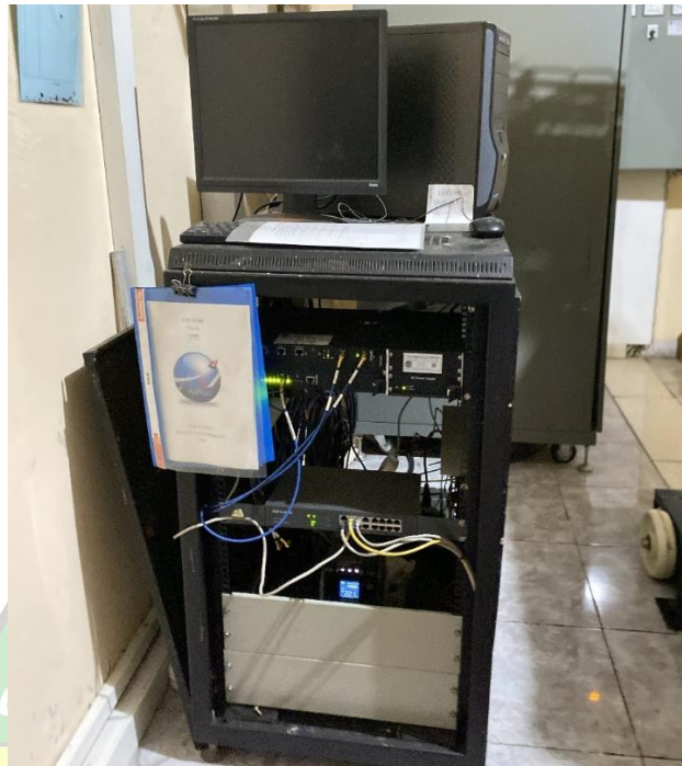
Gambar 3. 19 Kabinet ADSB THALES Sumber : Dokumentasi penulis 27 November 2023
