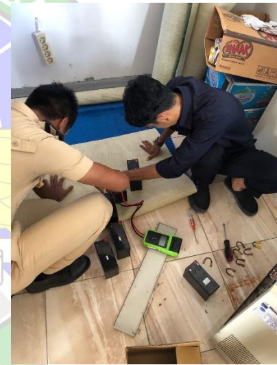
Perbaikan pada UPS dengan cara mengecek AKI apakah masih bisa berfungsi dengan baik atau tidak
