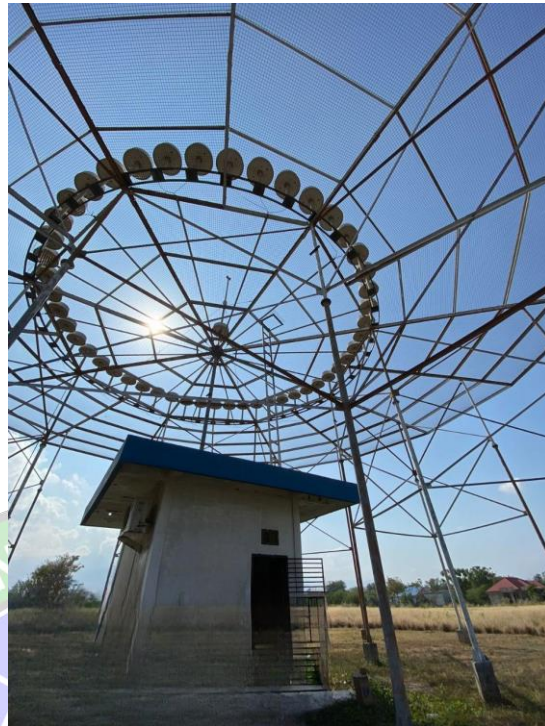
Gambar 3. 13Antena dan Shelter DVOR Sumber: Dokumentasi penulis 27 November 2023
