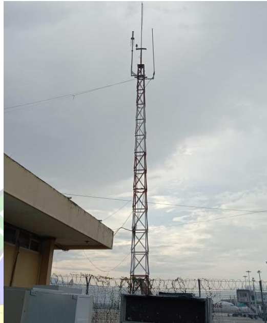
Gambar 3.3 Antena VHF A/G ( Primary ) TWR Sumber : Dokumentasi penulis 27 November 2023
