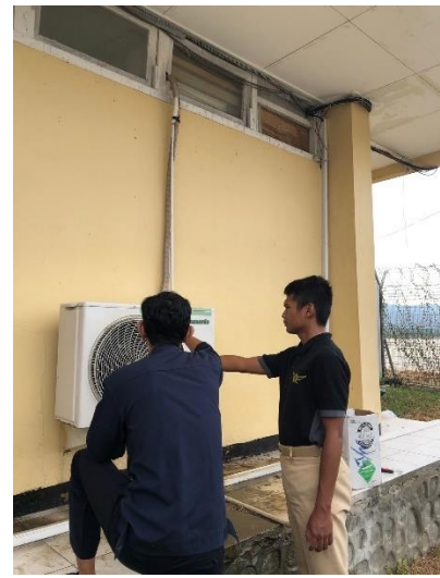
Pembersihan AC dengan cara mencuci AC luar
