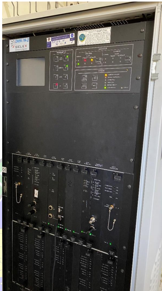
Gambar 3. 14 Kabinet DVOR SELEX Sumber : Dokumentasi penulis 27 November 2023
