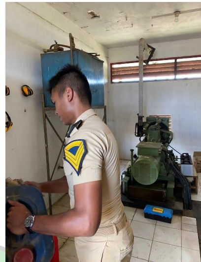
Pengisian solar yang terhubung dengan DVOR dan DME
