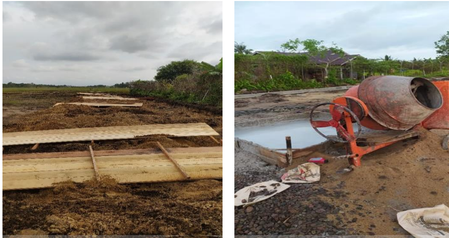
Gambar 4. 18 Pekerjaan Lantai Kerja
