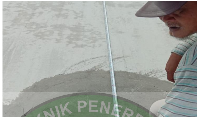
Gambar 4. 37 lapisan permukaan beton kering
