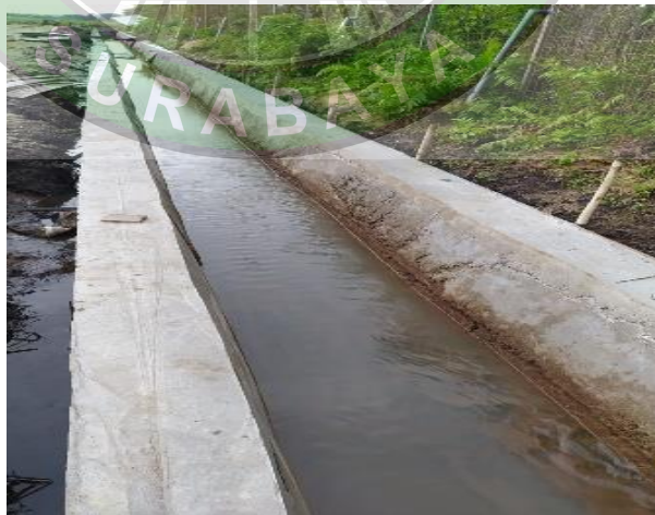
Gambar 4.22 Dinding Bekisting telah dilepas
