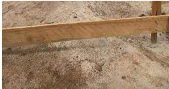
Gambar 4. 28 gambar bouwplank
