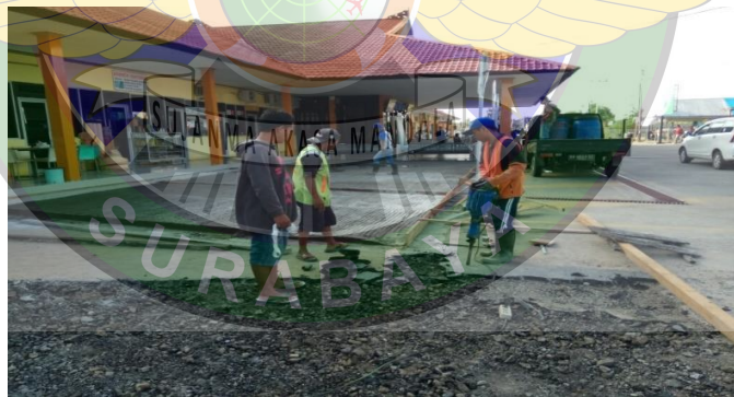
Gambar 4. 27 pembongkaran perkerasan yang rusak
