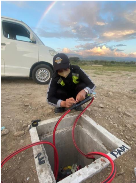
Pemberian resin pada kabel PAPI
