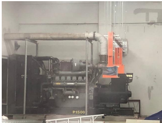
Gambar 4. 3 Genset 1500 KVA Sumber : Bandar Udara Mutiara Sis Al-Jufri Palu
