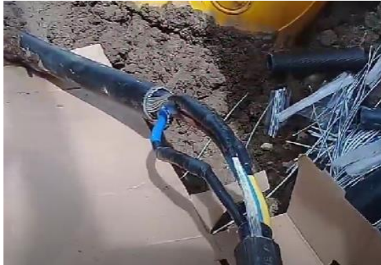
Gambar 4. 23 Beri solasi pada kabel
