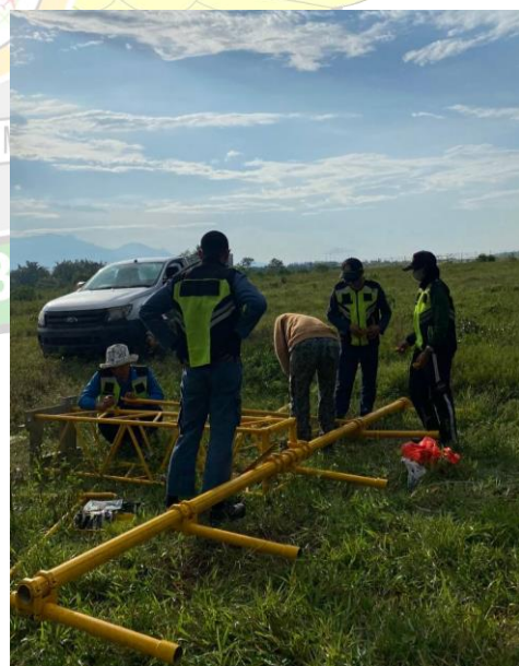
Pemasangan tiang pada lampu Approach
