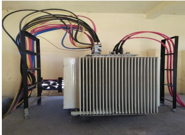
Gambar 4. 6 Transformator Daya Sumber : Bandar Udara Mutiara Sis Al-Jufri Palu
