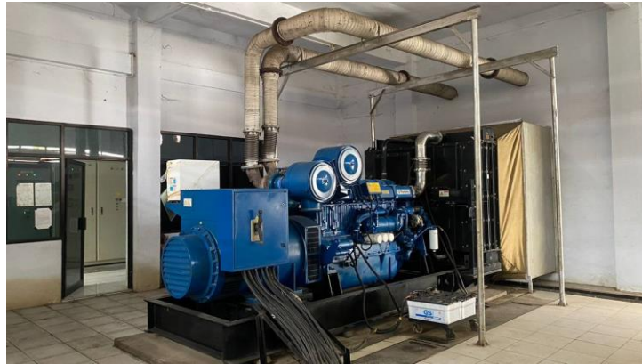
Gambar 4. 2 Genset 1000 KVA Sumber : Bandar Udara Mutiara Sis Al-Jufri Palu
