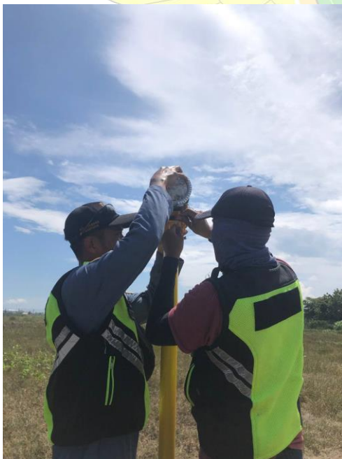
Pemasangan lampu Approach
