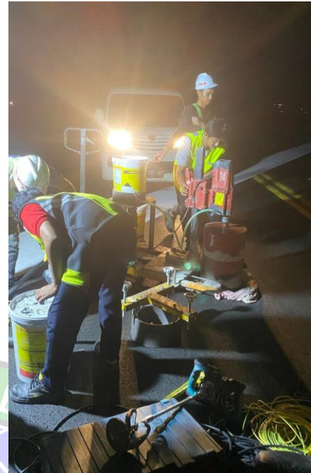
Pemasangan lampu insert
