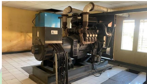
Gambar 4. 1 Genset 500 KVA Sumber : Bandar Udara Mutiara Sis Al-Jufri Palu
