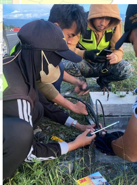
Pemasangan trafo pada Lampu runway
