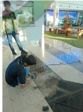
Gambar 4. 24 Proses Pemotongan Keramik Pecah
