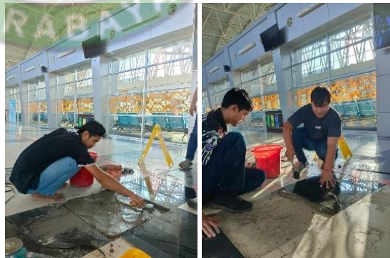
Gambar 4. 28 Proses Penuangan Spesi dan Pemasangan Keramik
