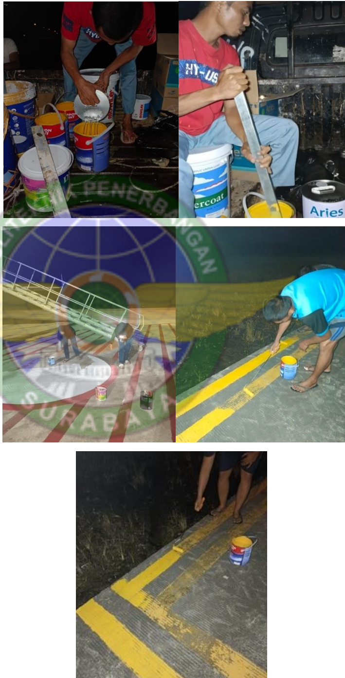
Gambar 4. 17 Proses Pencampuran Cat dengan Thinner dan Proses Pengecatan
