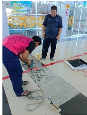
Gambar 4. 25 Proses Perusakan Spesi Lama Menggunakan Jack Hammer
