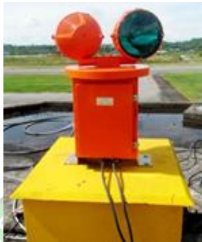
Gambar 2. 22 Rotating Beacon Sumber : Bandara Internasional Juwata Tarakan
