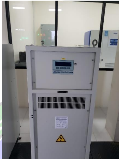
Gambar 2. 31 CCR Augier Type DIAM 4100 Sumber : Bandara Internasional Juwata Tarakan
