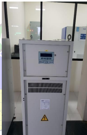
Gambar 2. 30 CCR Augier Type DIAM 4000 Sumber : Bandara Internasional Juwata Tarakan
