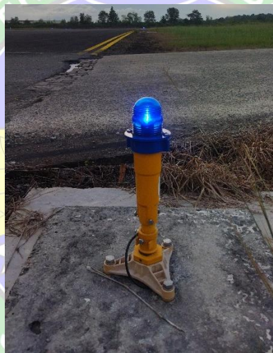
Gambar 2. 20 Taxiway Edge Light Sumber : Bandara Internasional Juwata Tarakan
