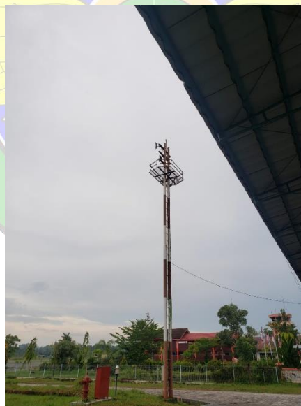
Gambar 2. 26 Flood Light Tiang Ganda Sumber : Bandara Internasional Juwata Tarakan
