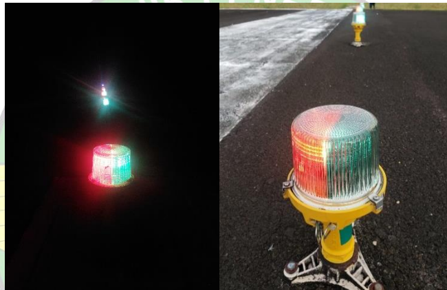
Gambar 2. 21 Threshold Light dan Runway End Light Sumber : Bandara Internasional Juwata Tarakan
