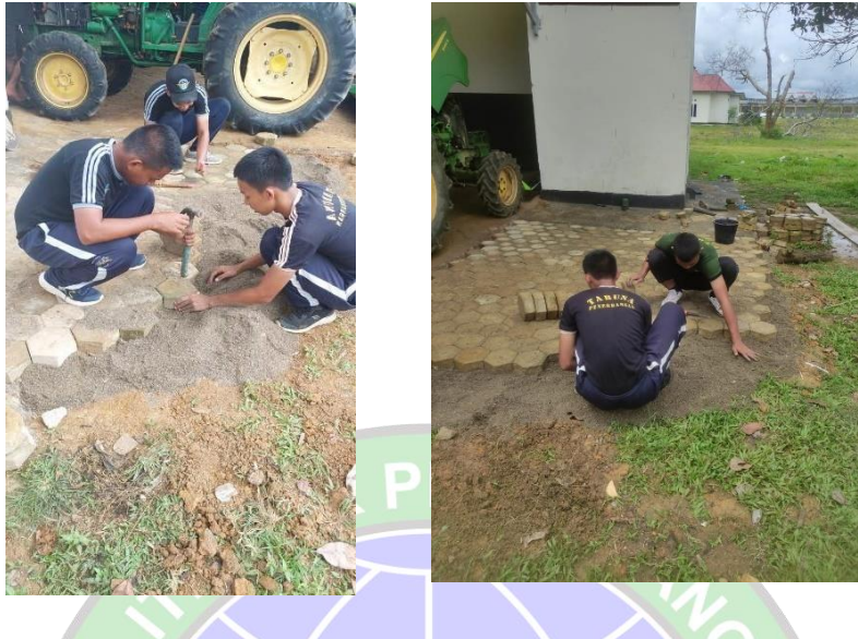
Gambar 4.12 Penghamparan Pasir dan Pemasangan Paving Block
