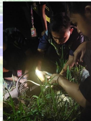
Pengukuran tahanan isolasi kabel FL2XCY Runway
