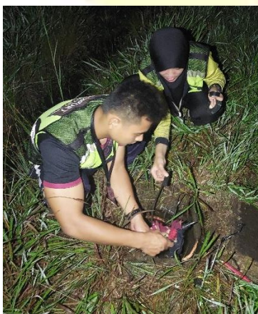
Pembersihan Connector Kit kabel FL2XCY
