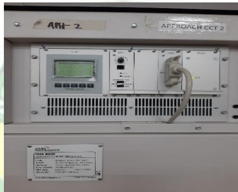
Gambar 2. 20 CCR ADB untuk Circuit Approach
