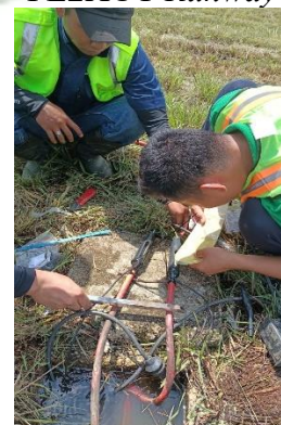
Pemasangan Connector Kit baru dan Resin
