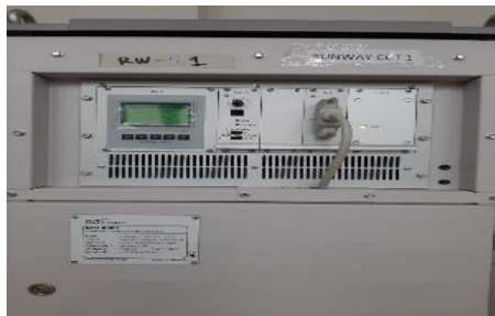
Gambar 2. 22 CCR untuk Circuit Runway
