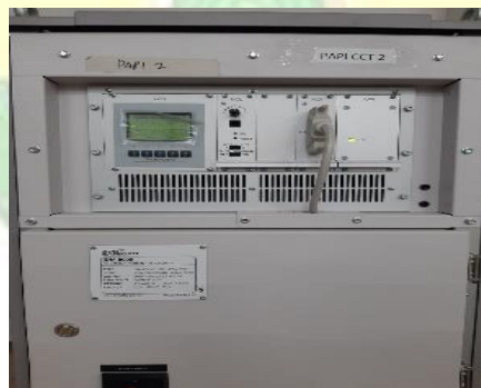
Gambar 2. 21 CCR untuk Circuit PAPI
