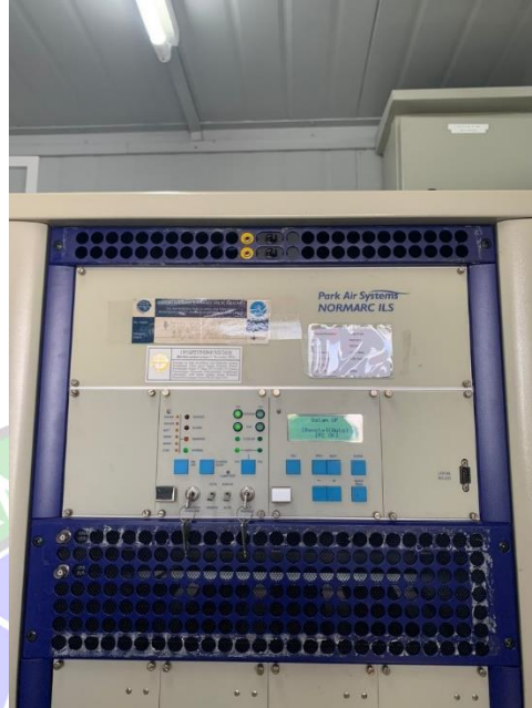
Gambar 3. 13 Transmitter Glide Path Sumber : Dokumentasi Penulis, 2023
