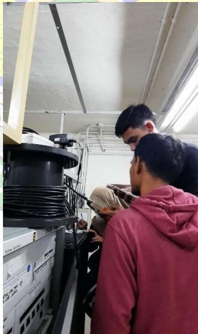
Gambar 3. 25 Pelepasan Sambungan Antena Sumber: Dokumentasi Penulis, 2023
