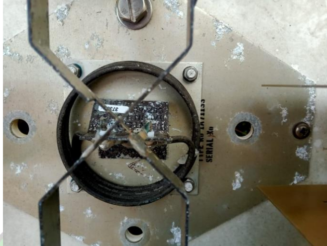
Gambar 3. 26 lokasi penyemprotan contact cleaner antenna DVOR Sumber: Dokumentasi Penulis, 2023
