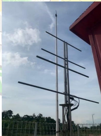
Gambar 3. 15 Antena Middle Marker Sumber : Dokumentasi Penulis, 2023
