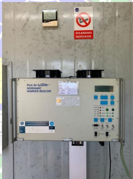
Gambar 3. 16 Transmitter Middle Marker Sumber : Dokumentasi Penulis, 2023
