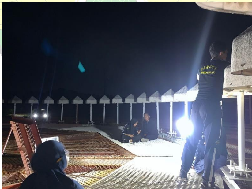
Gambar 3. 27 Tuning Antena DVOR Sumber: Dokumentasi Penulis, 2023
