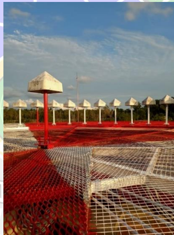
Gambar 3. 6 Antenna DVOR
