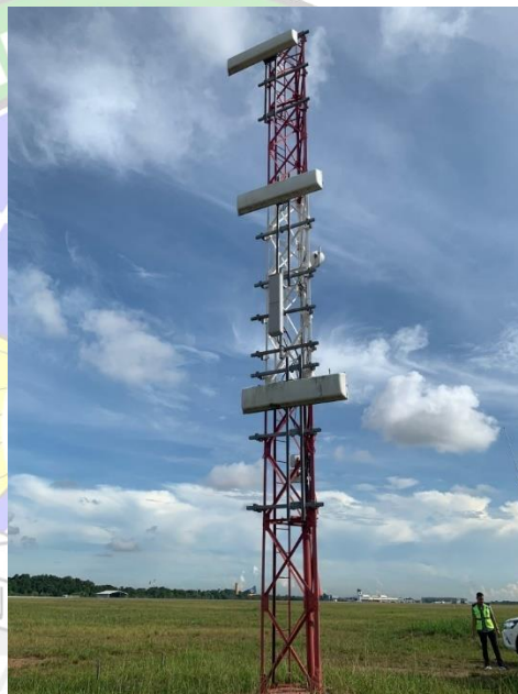
Gambar 3. 12 Antena Glide Path Sumber : Dokumentasi Penulis, 2023
