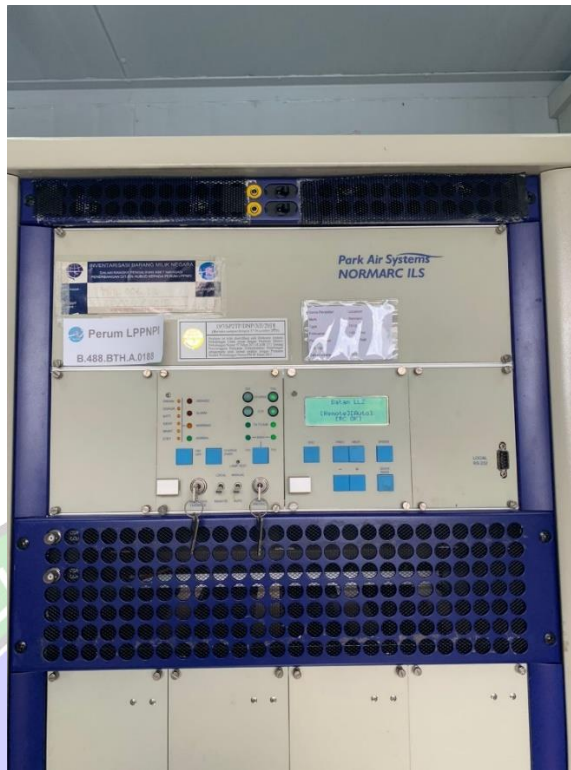
Gambar 3. 11 Modul Localizer NORMARC Sumber : Dokumentasi Penulis, 2023
