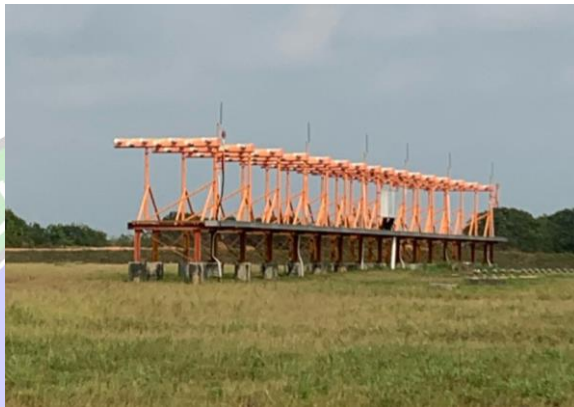
Gambar 3. 10 Antena Localizer Sumber : Dokumentasi Penulis, 2023
