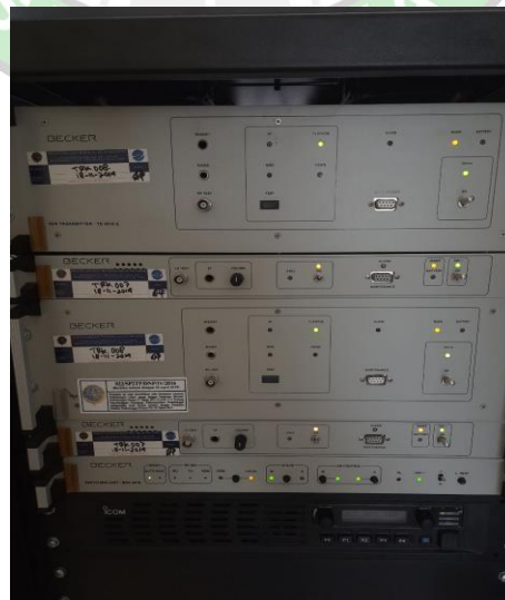
Gambar 3. 3 VHF A/G ADC Primary Sumber: Dokumentasi Penulis, 2023
