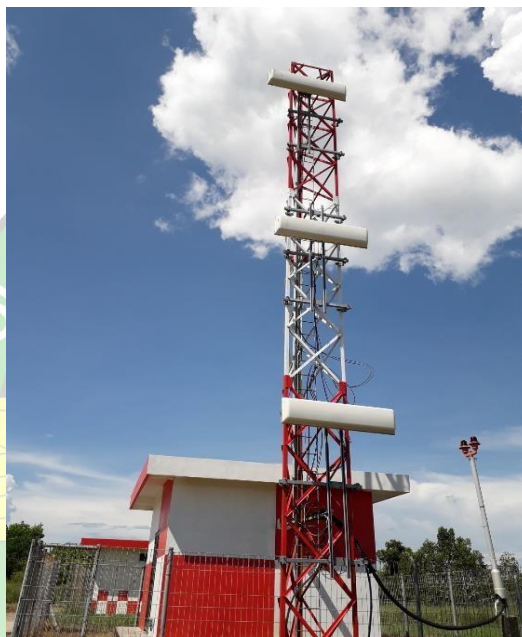
Gambar 3. 22 Antena Glide Path Sumber: Dokumentasi Penulis, 2023
