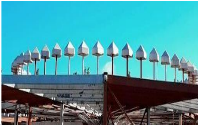
Gambar 3. 26 Antena DVOR Sumber: Dokumentasi Penulis, 2023
