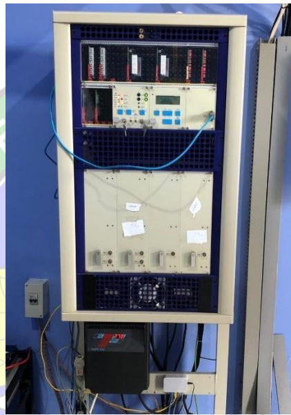
Gambar 3.42 Kabinet Glide Slope Sumber : Dokumentasi Penulis (2023)
