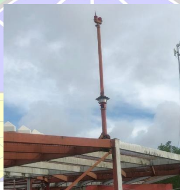
Gambar 3 33 Antena DME LBD yang Collocated dengan Antena DVOR Sumber : Dokumentasi Penulis (2023)
