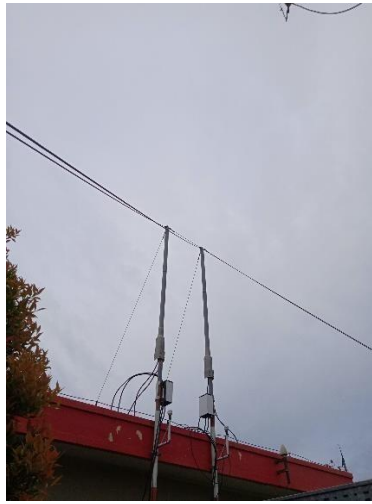
Gambar 3.51 Antena ADS-B Sumber : Dokumentasi Penulis (2023)
