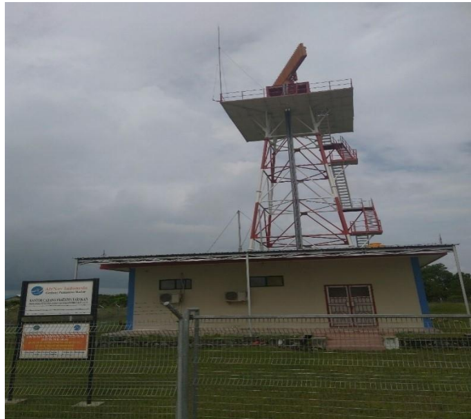
Gambar 3.48 Antena dan Gedung Radar MSSR Sumber : Dokumentasi Penulis (2023)
