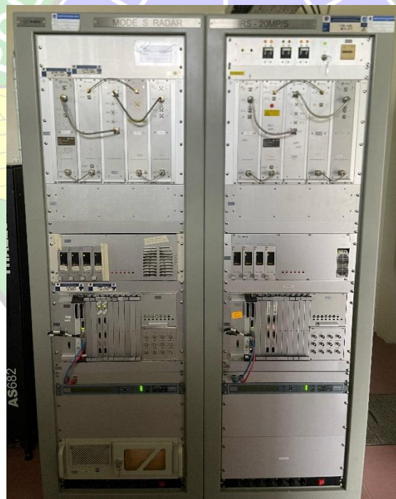
Gambar 3.47 Kabinet Radar Indra MSSR IRS-20MP/S Sumber : Dokumentasi Penulis (2023)
