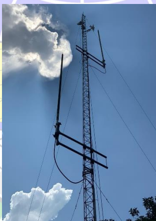
Gambar 3.25 Antena VHF-ER Makasar Secondary Sumber : Dokumentasi Penulis (2023)
