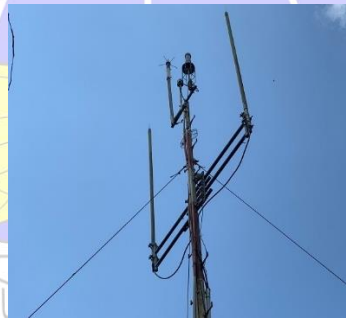
Gambar 3.22 Antena VHF-ER Primary Makasar 132.5 MHz Sumber : Dokumentasi Penulis (2023)
