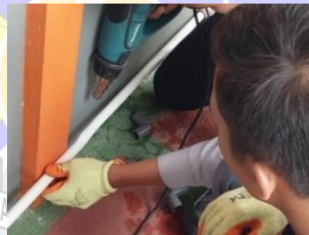
Gambar 4. 46 Memanasi pipa dengan hot gun (Sumber : Dokumentasi Penulis, 2024)
