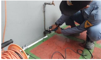
Gambar 4. 44 Memotong pipa dengan gerinda (Sumber : Dokumentasi Penulis, 2024)
