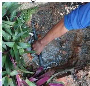
Gambar 4. 63 Crosscheck pipa (Sumber : Dokumentasi Penulis, 2024)
