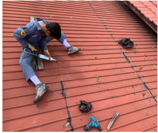
Perbaikan Atap Bocor
