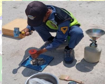
Gambar 4. 24 Menggali Tanah (Sumber : Dokumentasi Penulis, 2024)
