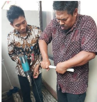
Gambar 4. 56 Pembuatan pipa sambungan (Sumber : Dokumentasi Penulis, 2024)
