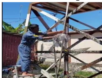
Gambar 4. 55 Menutup pipa dengan dop (Sumber : Dokumentasi Penulis, 2024)
