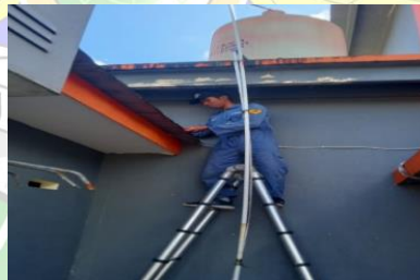
Gambar 4. 52 Menyambung pipa suplai (Sumber : Dokumentasi Penulis, 2024)
