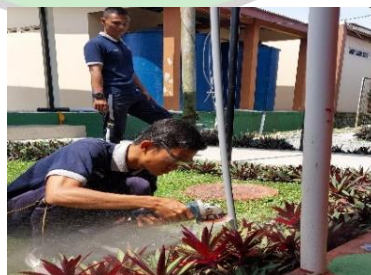
Gambar 4. 47 Memotong pipa suplai (Sumber : Dokumentasi Penulis, 2024)
