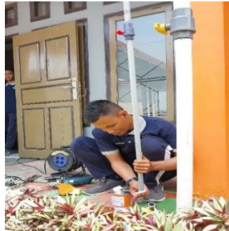
Gambar 4. 48 Menyambung pipa suplai (Sumber : Dokumentasi Penulis, 2024)
