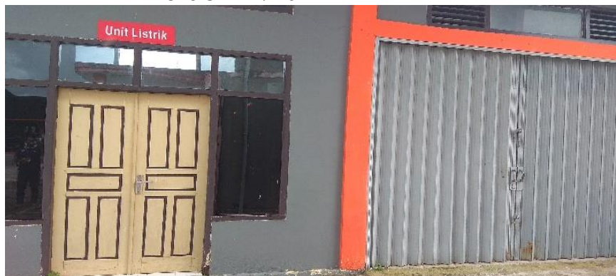
Gambar 4. 12 Gedung Main Power House (Sumber : Dokumentasi Penulis, 2024)
