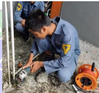
Gambar 4. 51 Memotong pipa dalam (Sumber : Dokumentasi Penulis, 2024)
