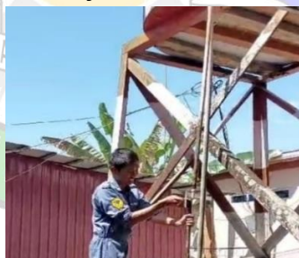
Gambar 4. 54 Pemotongan pipa (Sumber : Dokumentasi Penulis, 2024)
