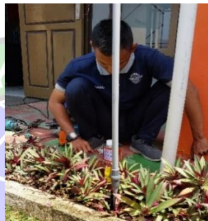
Gambar 4. 49 Memasang stop keran (Sumber : Dokumentasi Penulis, 2024)
