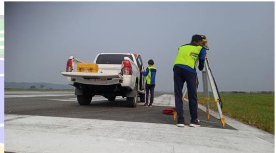
Mengukur Marka Sebelum Dilakukan Pengecatan
