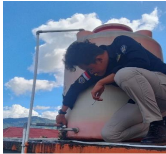
Gambar 4. 50 Menutup aliran tandon (Sumber : Dokumentasi Penulis, 2024)
