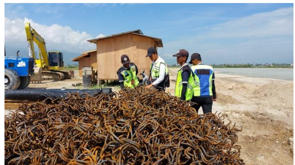
Pengecekan Besi Tulangan Apron
