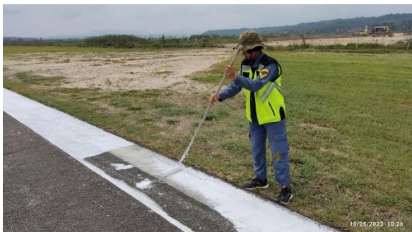
Pengecatan Marka Runway
