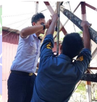
Gambar 4. 57 Pemasangan pipa sambungan (Sumber : Dokumentasi Penulis, 2024)
