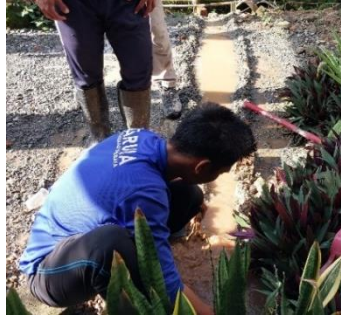
Gambar 4. 58 Menggali lokasi kebocoran (Sumber : Dokumentasi Penulis, 2024)
