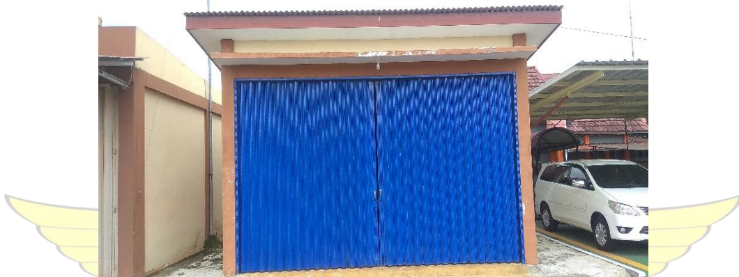
Gambar 4. 13 Gedung WTP Bandara Depati Parbo (Sumber: Dokumentasi Penulis, 2024)
