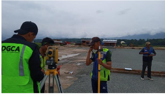
Pengukuran Level Agregat
