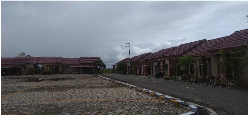
Gambar 4. 11 Komplek Perumahan Dinas Bandara Depati Parbo (Sumber: Dokumentasi Penulis, 2024)
