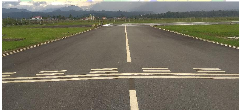
Gambar 4. 2 Taxiway Bandara Depati Parbo (Sumber: Dokumentasi Penulis, 2024)
