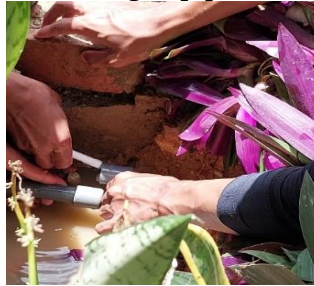
Gambar 4. 62 Mengganti pipa (Sumber : Dokumentasi Penulis, 2024)
