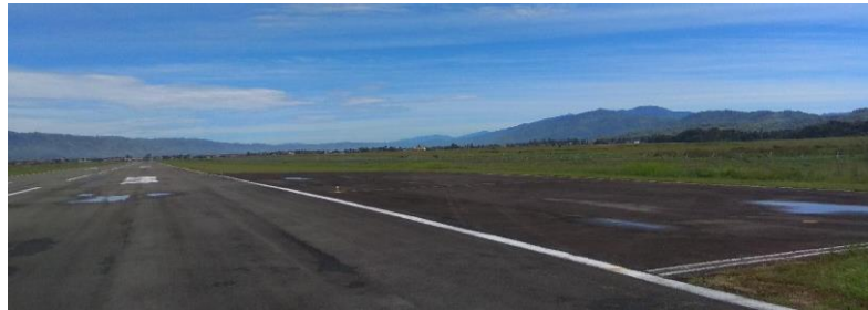
Gambar 4. 5 Turnpad Bandara Depati Parbo (Sumber: Dokumentasi Penulis, 2024)
