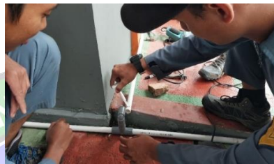
Gambar 4. 45 Memberi lem pada sambungan pipa (Sumber : Dokumentasi Penulis, 2024)
