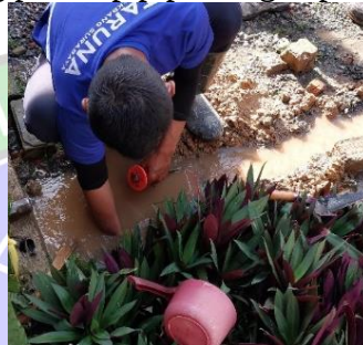
Gambar 4. 59 Menggempur dudukan pipa (Sumber : Dokumentasi Penulis, 2024)
