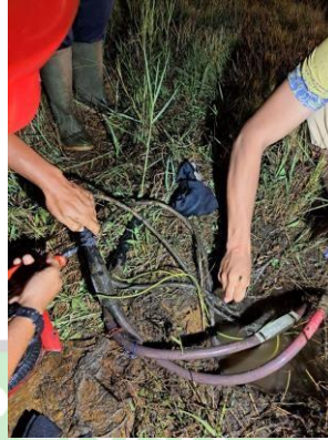
Gambar 4. 1 Pengecekan Tahanan Isolasi Lampu Runway Edge Circuit 2
