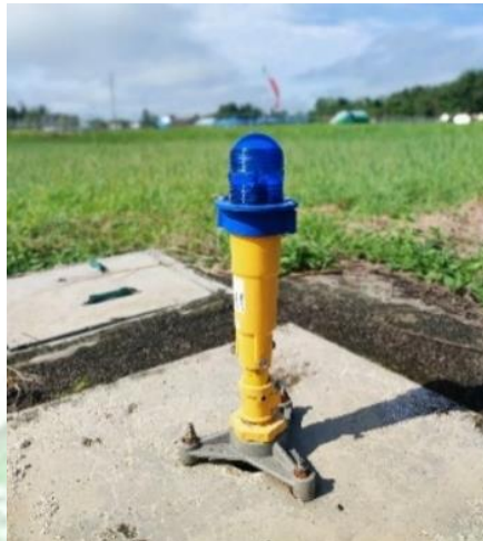
Gambar 2. 21 Taxiway Edge Light Sumber: Bandar Udara H. Asan Sampit
