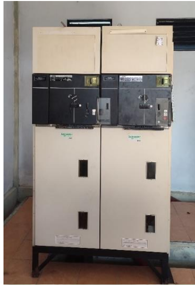
Gambar 2. 6 Cubicle Sumber : Bandar Udara H. Asan Sampit
