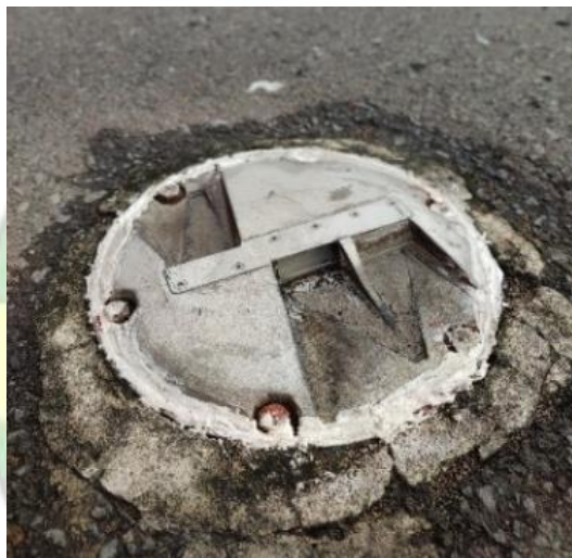
Gambar 2. 20 Runway Edge Light Insert Sumber: Bandar Udara H. Asan Sampit
