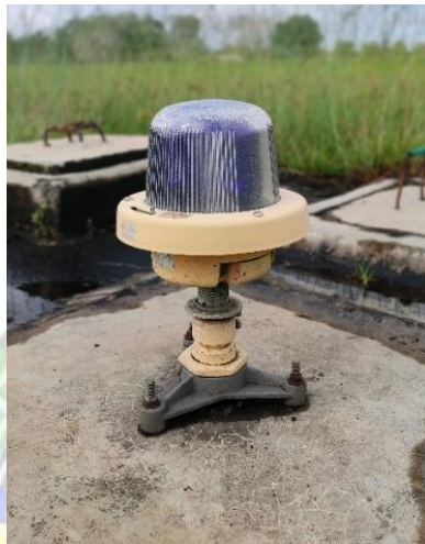
Gambar 2. 22 Turning Area Light Sumber: Bandar Udara H. Asan Sampit
