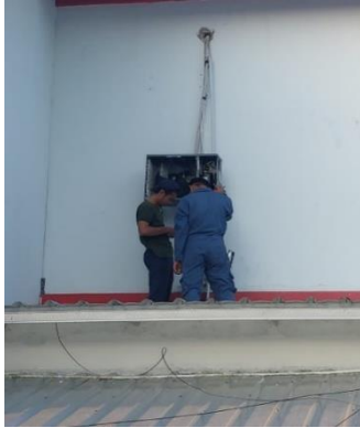
Penggantian Capacitor AC
