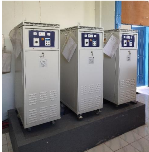
Gambar 2. 24 CCR Sumber: Bandar Udara H. Asan Sampit
