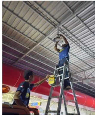
Pemasangan Lampu Terminal
