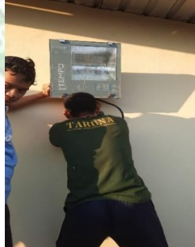
Pemasangan Lampu Sorot
