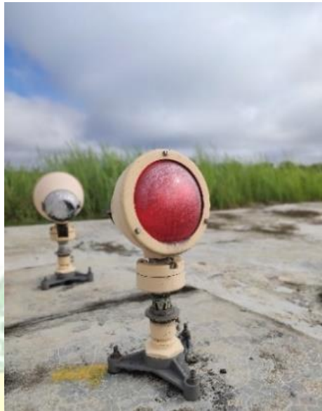
Gambar 2. 17 Runway End Light Sumber: Bandar Udara H. Asan Sampit
