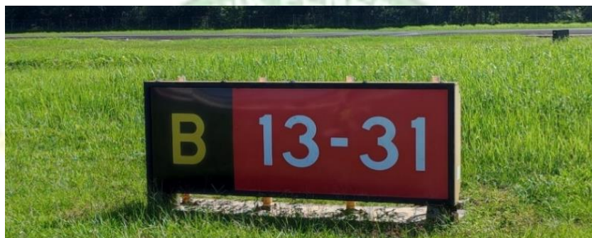
Gambar 2. 16 Taxiway Guidance Sign Sumber: Bandar Udara H. Asan Sampit
