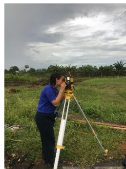
Gambar 4. 23 Pengukuran Area Runway Strip
