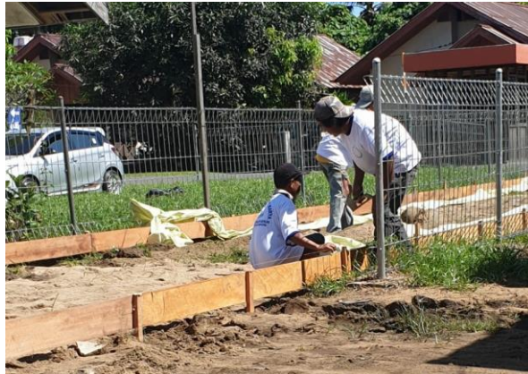
Gambar 4. 31 Pemasangan bekisting
