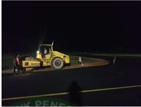
Gambar 4. 27 Pemadatan tanah dengan Vibrator Roller
