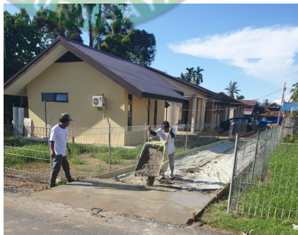
Gambar 4. 32 Tahap Pengecoran
