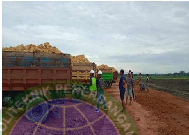
Gambar 4. 25 Pembongkaran Tanah Urug
