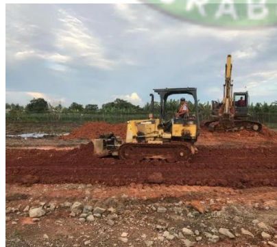
Gambar 4. 26 Perataan Tanah dengan bulldozer & grader
