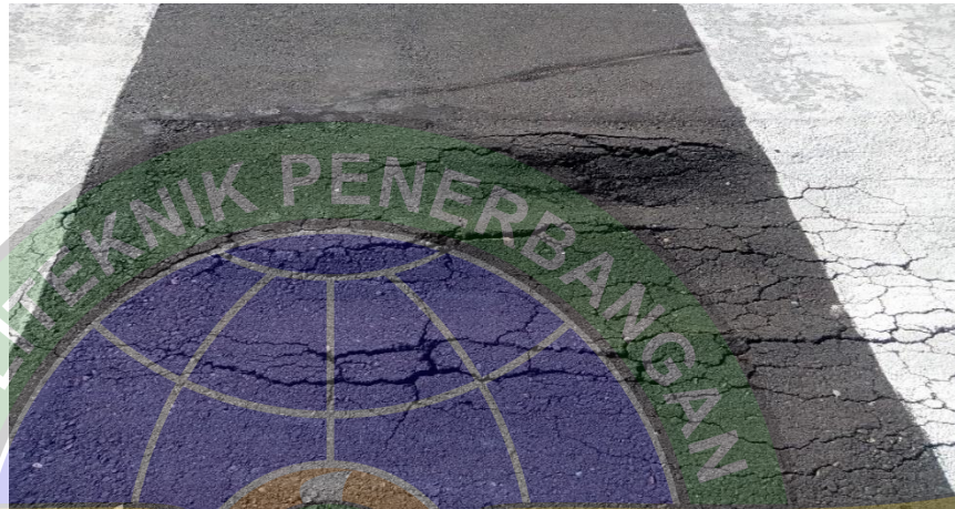
Gambar 4.15 Kondisi Area Threshold 11 yang Retak dan Bergelombang
