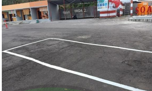
Gambar 4.19 Hasil Pengecatan Marka Parkir
