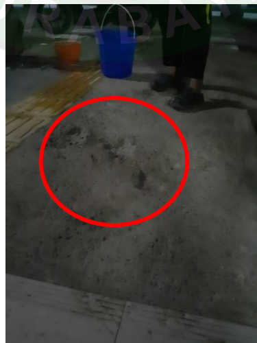
Gambar 4. 18 Lubang Ramp yang Dicor
