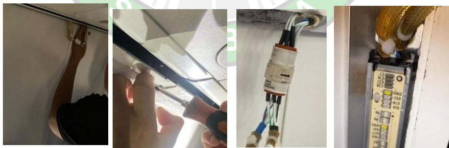
Gambar 4.11 Replace Window Lights (Sumber: Dokumen Pribadi)
