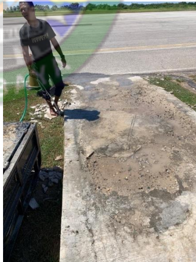
Gambar 4.21 Pembersihan Area Kerusakan Dengan Penyiraman
