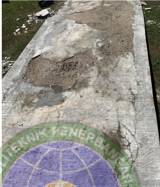
Gambar 4.14 Kerusakan Retak Geser-Lentur & Delamination (Permukaan Terkelupas)
