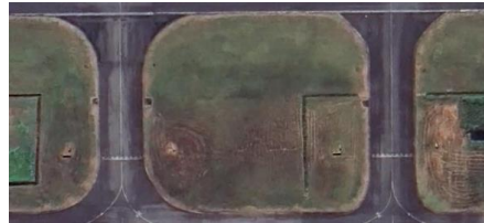
Gambar 4. 9 Tampak Atas Taxiway Bandar Udara Rahadi Oesman
