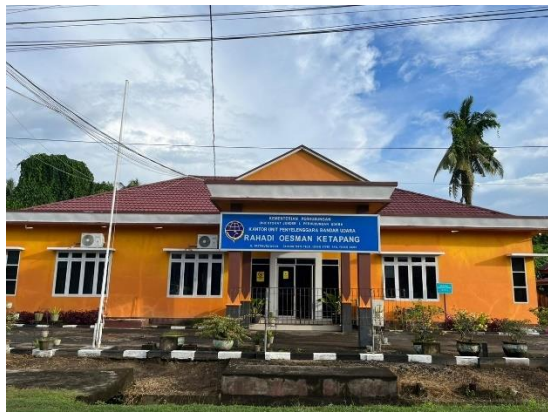
Gambar 4. 4 Gedung Administrasi Bandar Udara Rahadi Oesman
