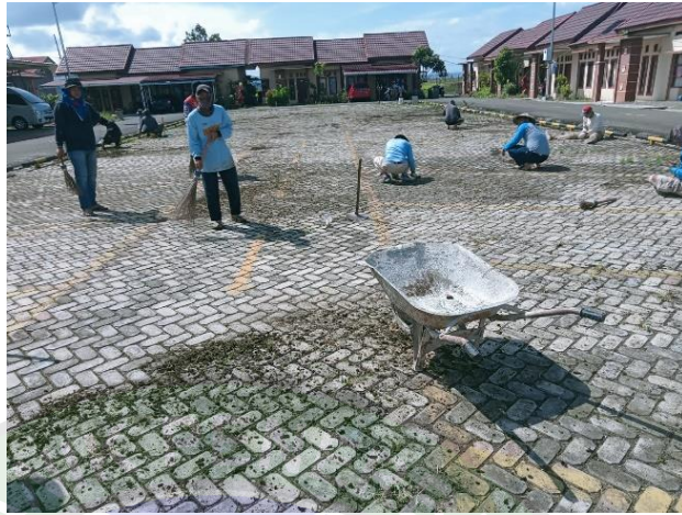
Gambar 4. 23 Pelaksanaan pembersihan lumut dari paving block (Sumber: Dokumentasi Penulis, 2023)
