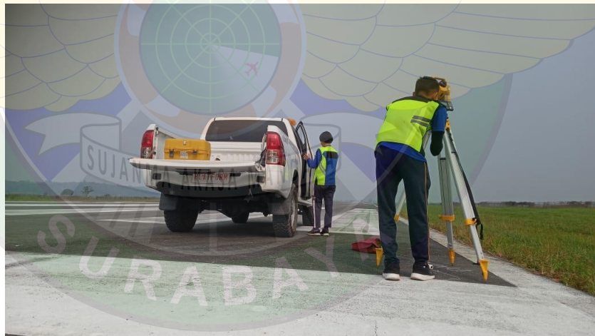
Gambar 4. 17 Pengukuran Marka Runway Side Strip (Sumber: Dokumentasi Penulis, 2023)
