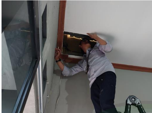
Perbaikan kebocoran pada atap gedung EOC
