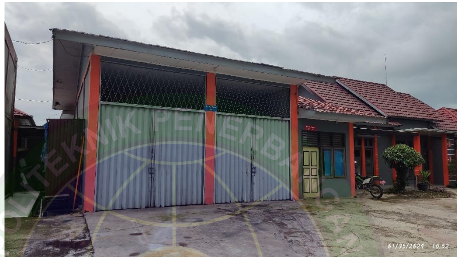
Gambar 4. 6 Gedung AAB Bandar Udara Depati Parbo Kerinci (Sumber: Dokumentasi Penulis, 2024)
