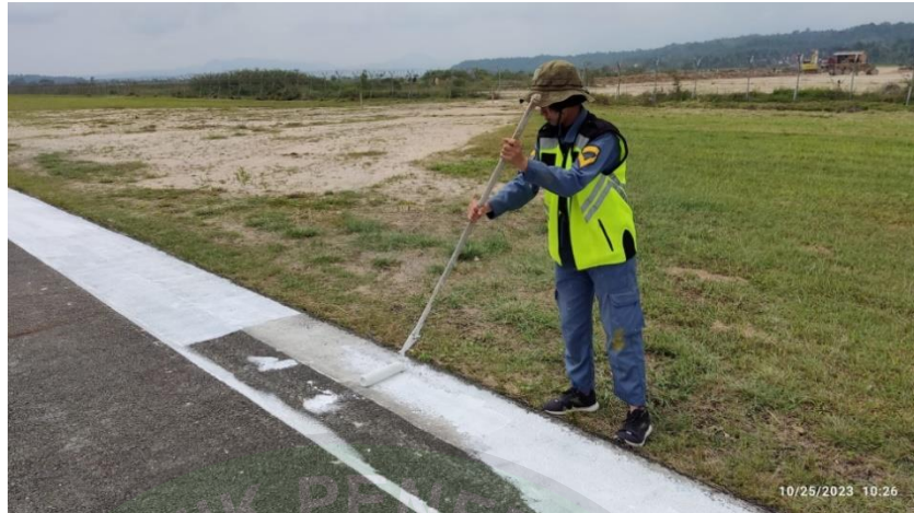
Gambar 4. 21 Pelaksanaan pengecatan marka runway side strip (Sumber: Dokumentasi Penulis, 2023)
