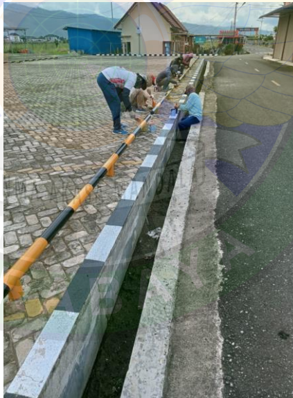
Gambar 4. 24 Pelaksanaan pengecatan marka pada parking area (Sumber: Dokumentasi Penulis, 2023)
