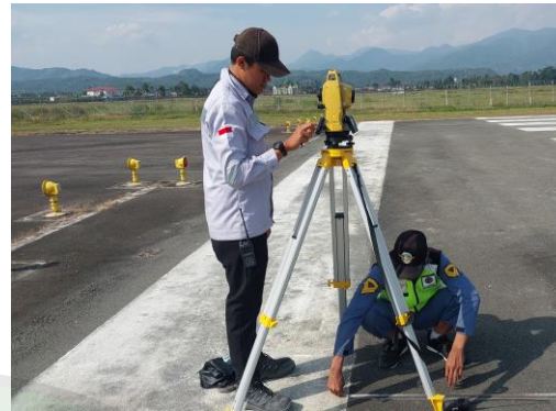
Pengukuran runway side strip marking menggunakan total station
