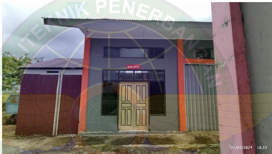
Gambar 4. 3 Main Power House Bandar Udara Depati Parbo Kerinci (Sumber: Dokumentasi Penulis, 2024)
