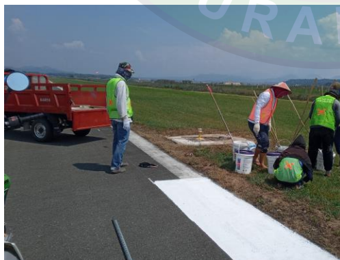
Pelaksanaan pengecatan marka runway side strip bersama pegawai bandara
