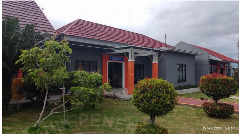
Gambar 4. 4 Gedung Administrasi Bandar Udara Depati Parbo Kerinci (Sumber: Dokumentasi Penulis, 2024)
