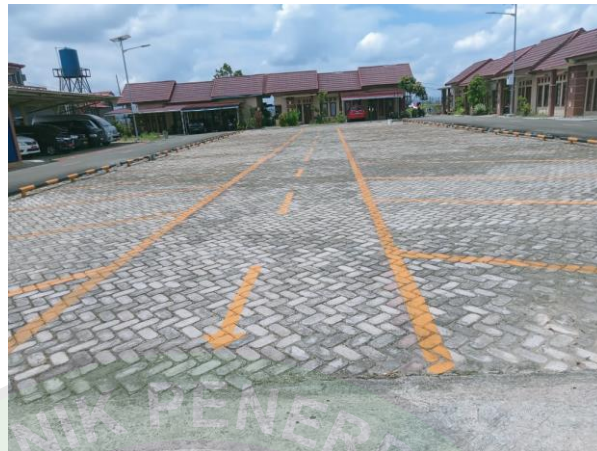
Gambar 4. 25 Hasil pengecatan marka pada parking area (Sumber: Dokumentasi Penulis, 2023)
