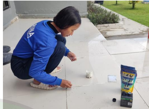
Pemasangan nut pada keramik kantor administrasi
