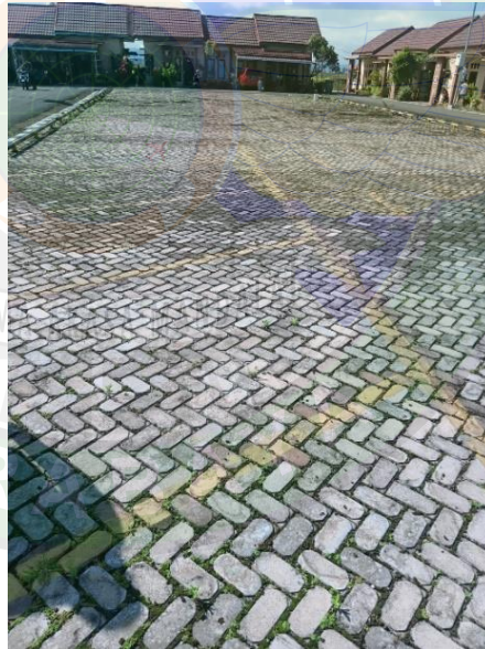
Gambar 4. 22 Penampakan parking area sebelum dibersihkan dan di cat (Sumber: Dokumentasi Penulis, 2023)
