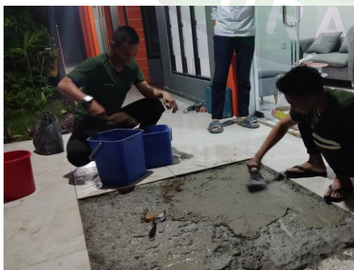
Perbaikan keramik pada teras gedung administrasi
