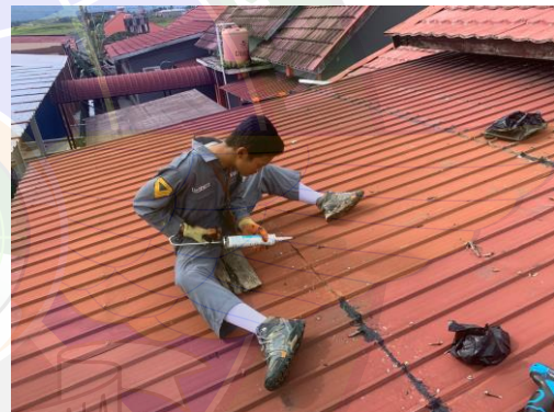
Perbaikan kebocoran atap pada ruang material dengan sealant
