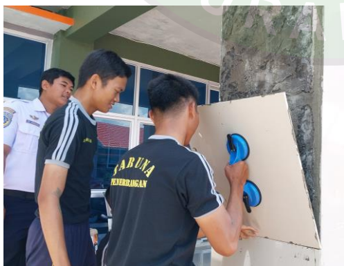
Perbaikan keramik pada tiang terminal keberangkatan
