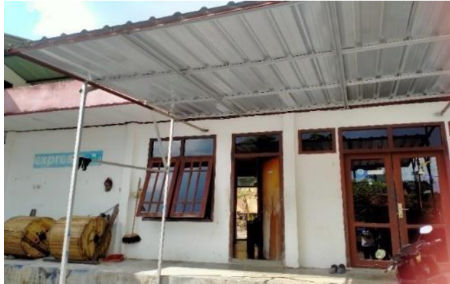
Gambar 2. 23 Bangunan Ruang Listrik dan CCR
