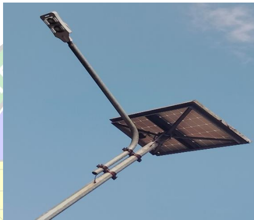
Gambar 3. 1 Solar Cell pada PJU Bandara Iskandar Sumber : Penulis, 2023
