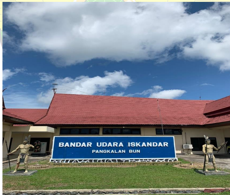
Gambar 2. 1 Bandar Udara Iskandar Pangkalan Bun
