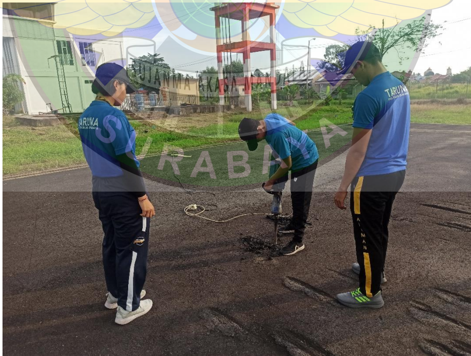
Patching Kerusakan Pada Apron
