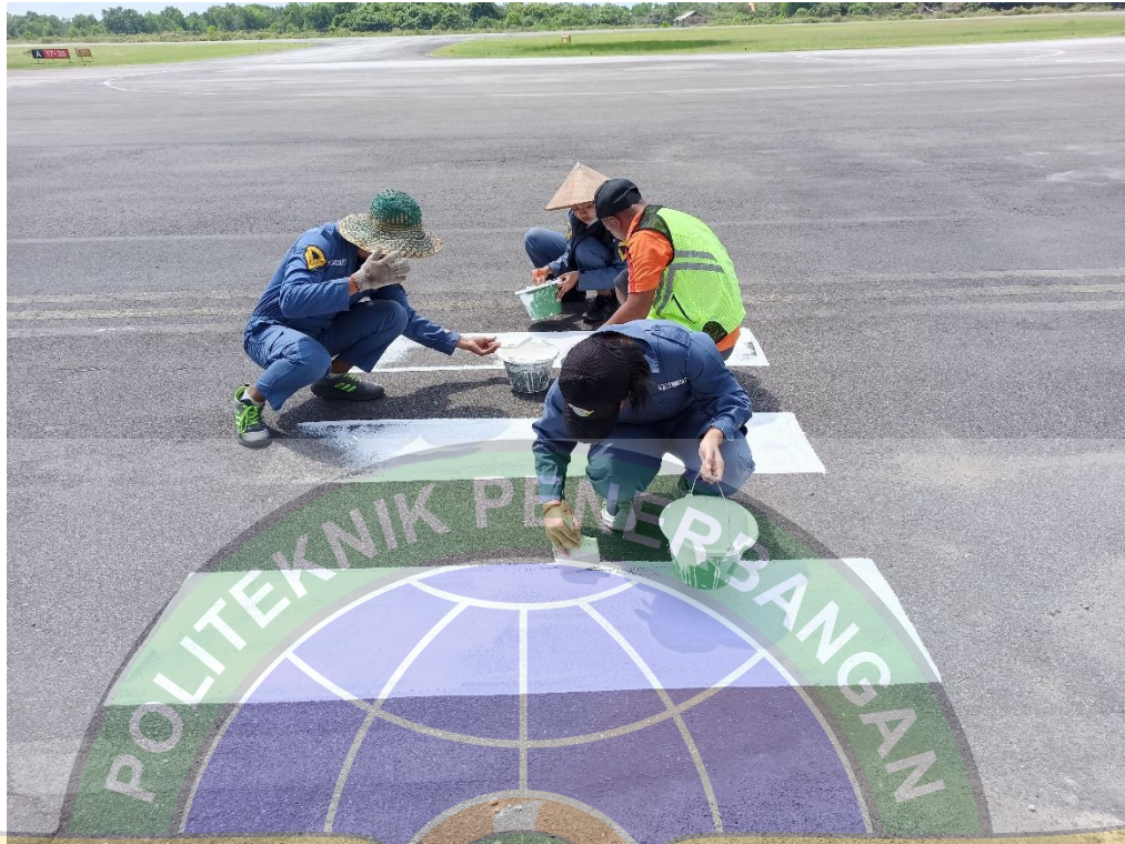
Pengecatan Marka
