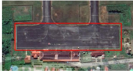
Gambar 4. 3 Apron Bandar Udara Rahadi Oesman
