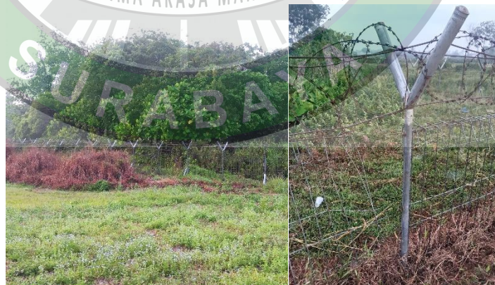
Gambar 4. 15 Pagar Perimeter Tinggi 1,8 Meter
