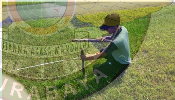
Gambar 4. 16 Proses Pemasangan Patok Penanda
