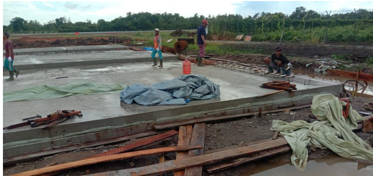
Gambar 4. 36 Penutupan Area Pengecoran
