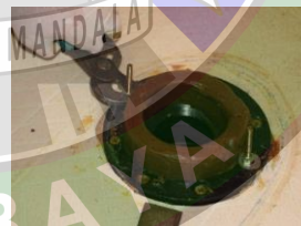
Gambar 4. 43 Pemasangan Seal Gasket
