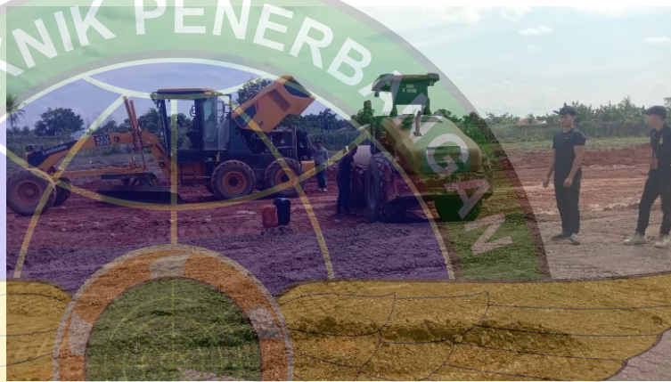
Gambar 4. 23 Proses Pemadatan Timbunan
