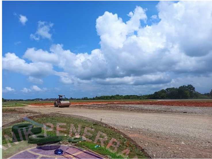
Gambar 4. 25 Pemadatan Material Agregat
