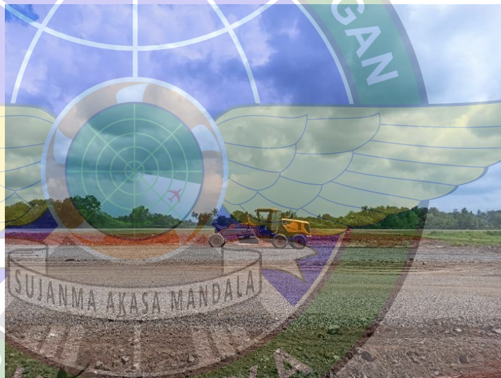
Gambar 4. 25 Penghamparan Material Menggunakan Motor Grader
