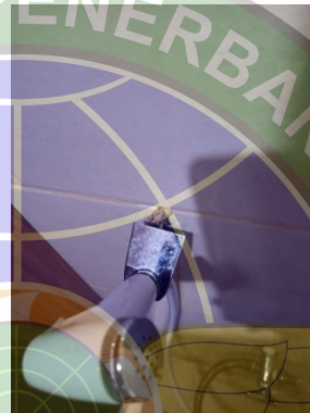
Gambar 4. 6 Pecahnya Pintu Kaca Buram Toilet Terminal
