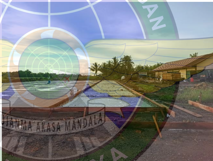
Gambar 4. 30 Pekerjaan Bekisting
