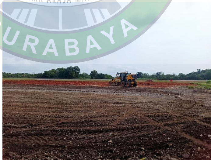
Gambar 4. 22 Proses Pemerataan Hamparan Tanah
