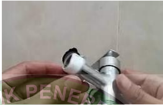
Gambar 4. 46 Pemasangan Mata Kran Air
