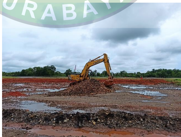
Gambar 4. 20 Proses Pekerjaan Timbunan
