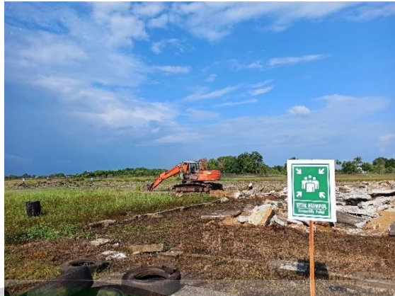
Gambar 4. 13 Proses Clearing Area Pembangunan Helipad
