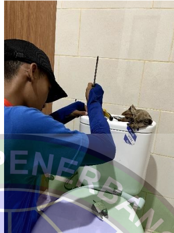
Gambar 4. 38 Pekerjaan Perbaikan Kloset Duduk
