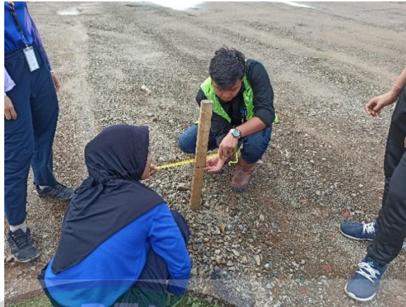
Gambar 4. 29 Pengukuran Elevasi Ketinggian
