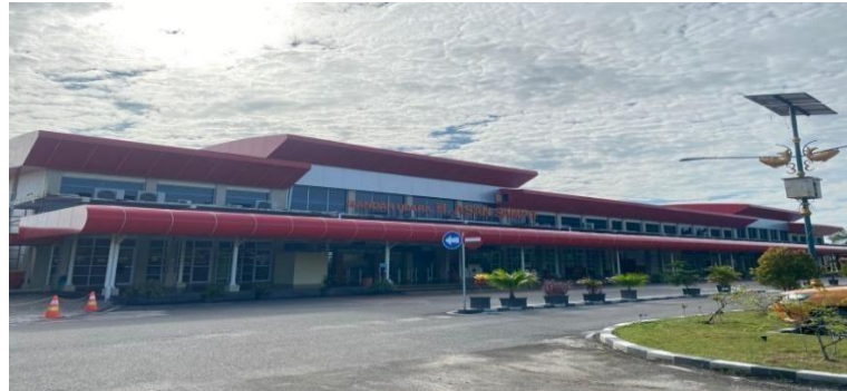
Gambar 2.1 Terminal UPBU H. Asan Sampit Sumber: Dokumen Bandar Udara H. Asan Sampit
