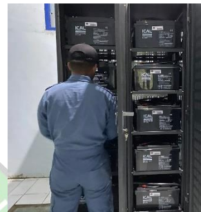
Perbersihan baterai UPS
