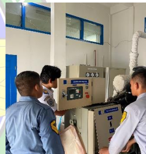
Perbaikan Genset 150KV
