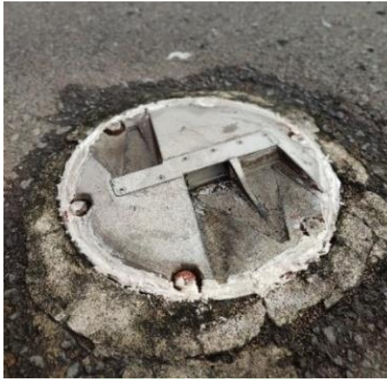
Gambar 2.21 Runway Edge Light Insert Sumber: Bandara UPBU H. Asan Sampit
