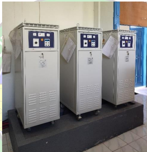
Gambar 2.25 CCR Sumber: Bandara UPBU H. Asan Sampit
