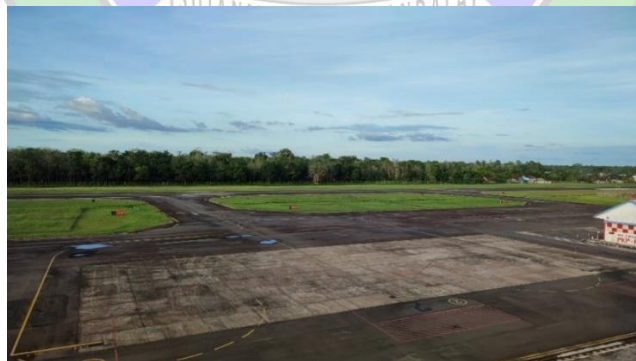
Gambar 2.14 Apron Sumber: Bandara UPBU H.Asan Sampit
