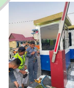
Pemasangan Lampu Pos
