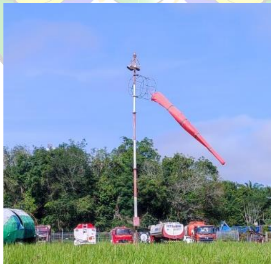
Gambar 2.32 Windcone Sumber: Bandara UPBU H. Asan Sampit
