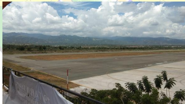
Gambar 2. 5 Taxiway Bandar Udara Mutiara Sis Al-Jufri
