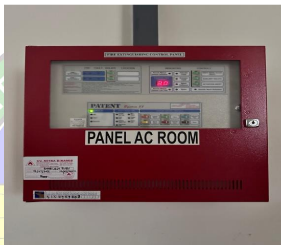
Gambar 3.25 Panel Fire Alarm Sumber: Dokumentasi Penulis, 2024
