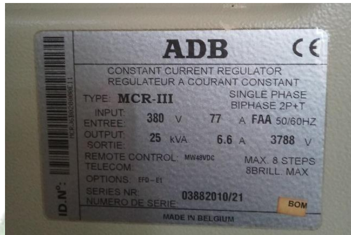
Gambar 2.32 CCR Runway Edge Light rangkaian II
