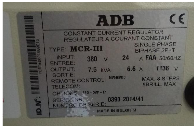
Gambar 2.35CCR Taxiway Edge Light Rangkaian A dan B
