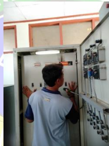
Gambar 4. 18 Pasang kembali penutup panel CCR
