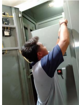
Gambar 4. 11 Buka penutup panel distribusi UPS
