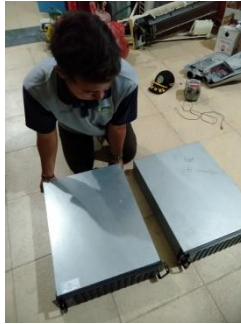
Gambar 4. 4 Melepas 2 modul dari UPS
