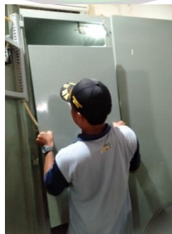
Gambar 4. 13 Pasang kembali penutup panel
