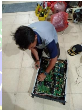
Gambar 4. 7 Melepas PCB Rectifier dan PCB Inverter
