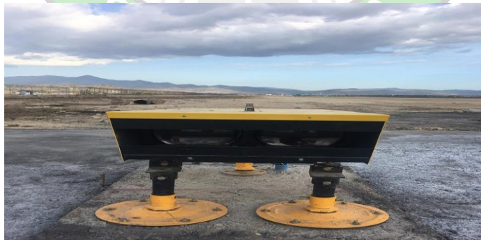
Gambar 2. 7 Path Approach Precision Indicator (PAPI) Sumber : Bandar Udara Sultan Muhammad Salahuddin Bima
