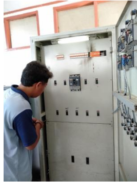
Gambar 4. 14 Buka Penutup Panel CCR
