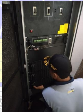
Gambar 4. 10 Pasang kembali modul pada UPS
