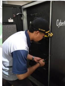
Gambar 4. 3 Membuka case pada UPS Sumber : Bandar Udara Sultan Muhammad Salahuddin Bima
