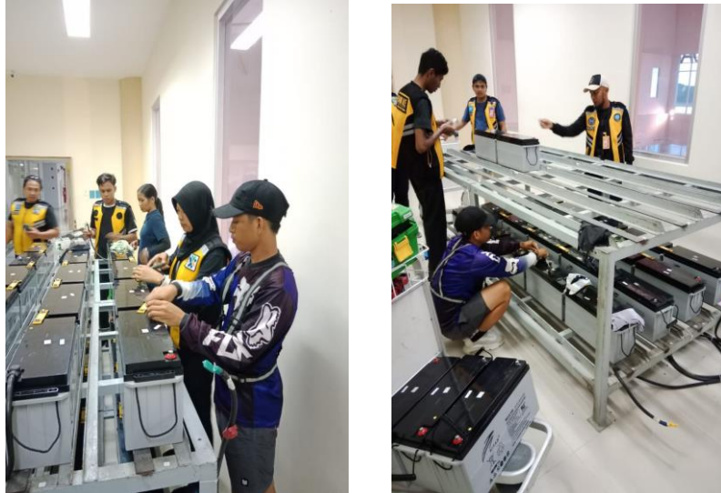
Gambar 4. 4 Pembongkaran Baterai UPS 80 kVA pada gedung terminal Sumber : Bandara Juwata Tarakan
