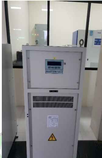
Gambar 2. 30 CCR Augier Type DIAM 4000 Sumber : Bandara Juwata Tarakan
