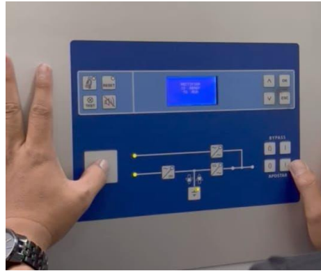
Gambar 4. 10 Memasukkan input UPS Sumber : Bandara Juwata Tarakan
