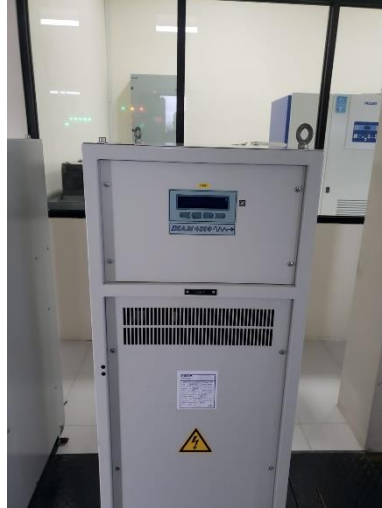
Gambar 2. 31 CCR Augier Type DIAM 4100 Sumber : Bandara Juwata Tarakan
