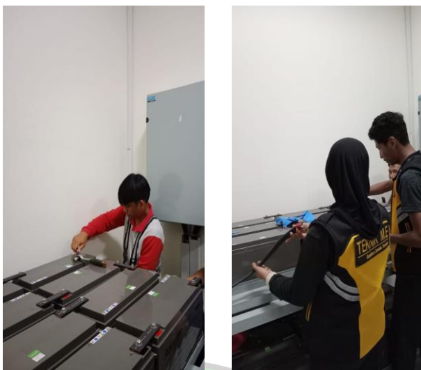
Gambar 4. 6 Pembongkaran baterai UPS 160kVA merk ROCKET Gedung Substation
