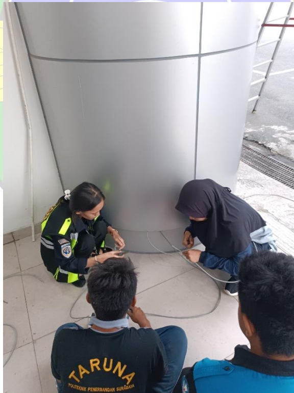
Mengupas kabel LAN sebagai pengganti kabel Telepon
