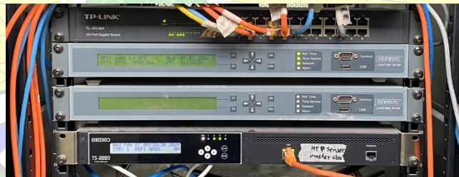
Gambar 3. 16 Master Clock Server Sumber: Dokumentasi Penulis 12 Februari 2024
