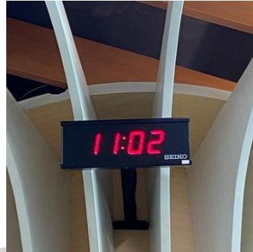
Gambar 3. 17 Master Clock Client Sumber: Dokumentasi Penulis 12 Februari 2024
