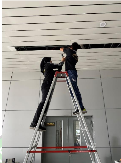
Pengecekan sambungan kabel telepon Garbarata 1
