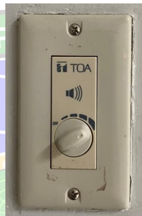
Gambar 3. 8 Terminal Volume Speaker Sumber: Dokumentasi Penulis 12 Februari 2024
