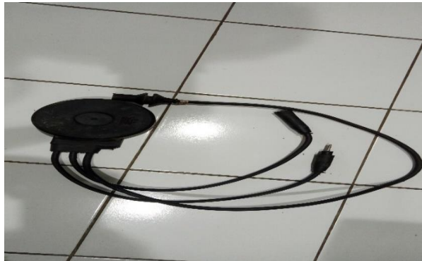
Gambar 2. 14 Series Transformator Sumber : Bandara Internasional Husein Sastranegara
