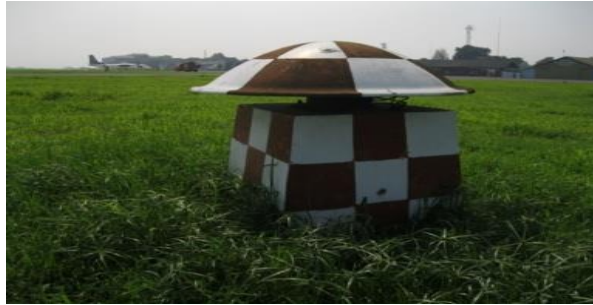
Gambar 2. 19 Sirine (Horn) Sumber : Bandara Internasional Husein Sastranegara
