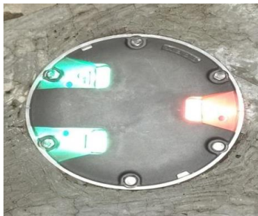
Gambar 2. 8 Runway Edge Light Insert Sumber : Bandara Internasional Husein Sastranegara
