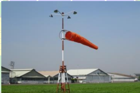
Gambar 2. 22 Wind Cone Sumber : Bandara Internasional Husein Sastranegara
