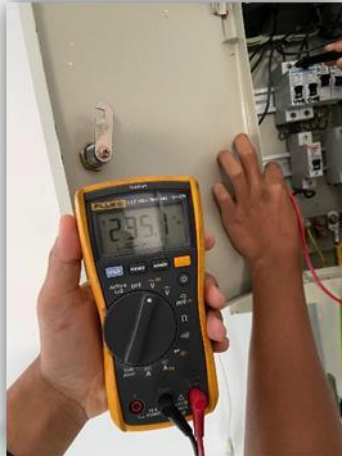
Gambar 3. 38 Pengukuran supply daya pada panel box sesudah kabel tersambung
