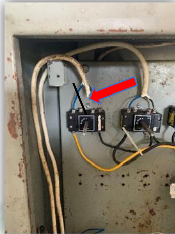
Gambar 3. 36 Penyambungan kabel pong pada panel distribusi DVOR dan DME
