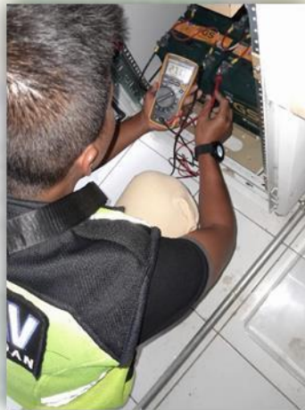
Gambar 3. 39 Pengukuran supply daya pada baterai sebelum kabel tersambung
