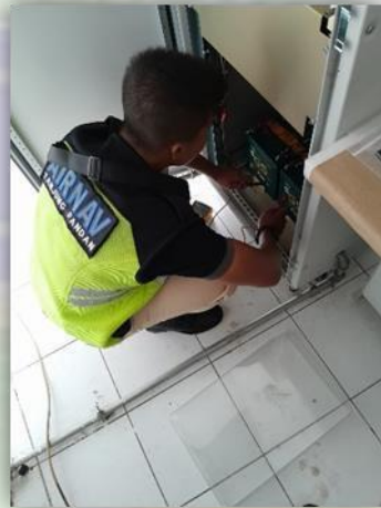
Gambar 3. 27 Pengecekan Supply Baterai DME
