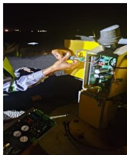
Gambar 4. 7 Mengganti PCB modul Sumber : dokumentasi penulis
