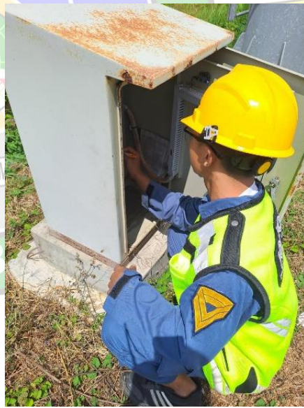
Gambar 5. 3 pemeliharaan panel floodlight
