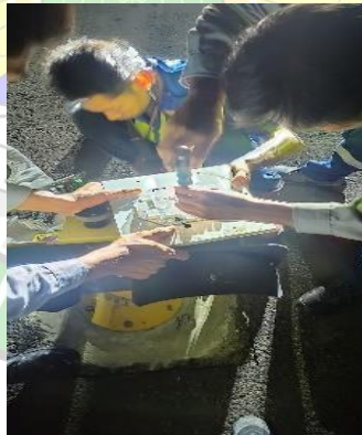
Gambar 4. 9 cek kabel penghubung PCB LED Sumber : dokumentasi penulis
