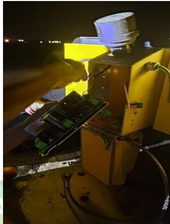
Gambar 4. 8 Menukar socket lampu PCB LED Sumber : dokumentasi penulis
