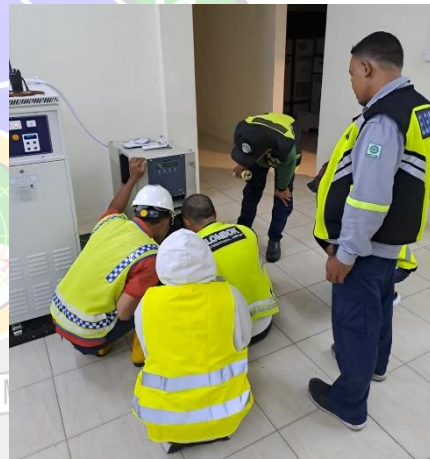
Gambar 5. 7 perbaikan CCR
