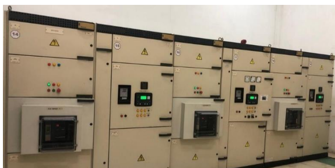
Gambar 2. 19 Genset Control Panel Sumber : Dokumentasi Pribadi
