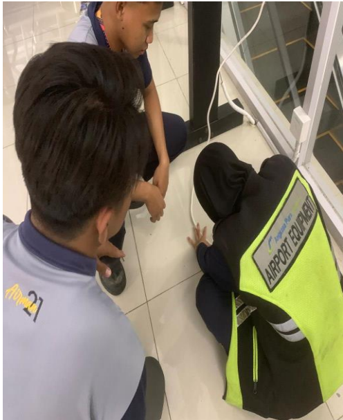
PEMASANGAN POWER TENANT
