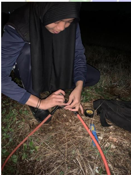
PERBAIKAN RUNWAY EDGE LIGHT
