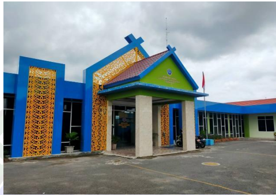
Gambar 4. 6 Bangunan Kantor ( Sumber : Dokumentasi Pribadi, 2023)
