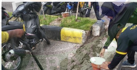
Gambar 4. 26 Proses pemasangan kanstin
