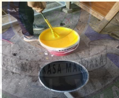
Gambar 4. 10 Pencampuran cat dengan air
