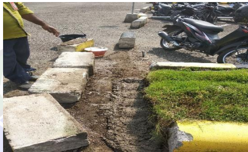
Gambar 4. 25 Proses pemasangan mortar
