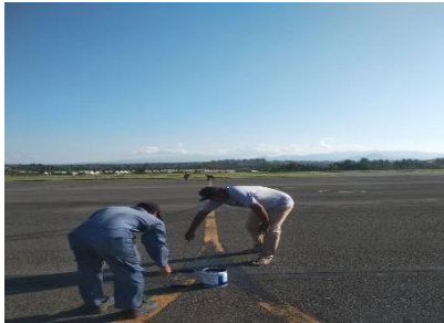
Gambar 4. 11 Penghapusan marka existing ( Sumber : Dokumentasi Pribadi, 2023)
