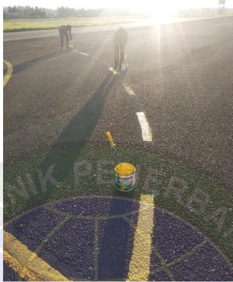
Gambar 4. 18 Pengecatan parking stand tidak kritis ( secondary )
