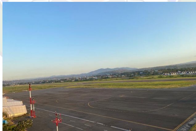
Gambar 4. 21 Hasil pengecatan 5 parking stand ( Sumber : Dokumentasi Pribadi, 2023)
