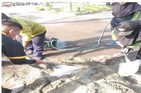
Gambar 4. 24 Proses pencampuran mortar
