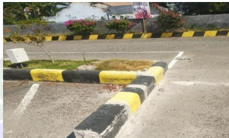
Gambar 4. 27 Hasil pemasangan kanstin ( Sumber : Dokumentasi Pribadi, 2023)
