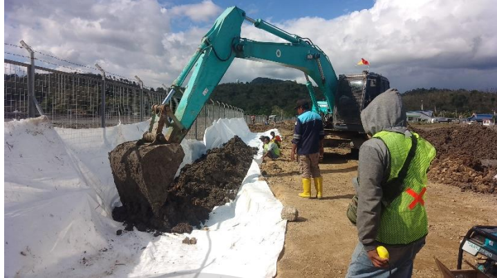
Gambar 4.18 penghamparan tanah pada area yang sudah dipasang geotextile
