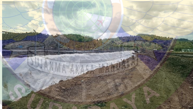
Gambar 4.19 Geotextile dengan tanah yang sudah jenuh
