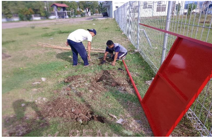
Gambar 4.13 pemasangan papan warning sign menggunakan metode cor
