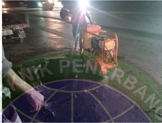
Gambar 4.11 Pembongkaran Ashpalt
