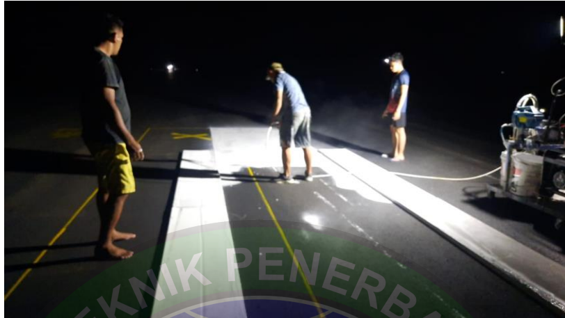
Gambar 4.23 Proses Pekerjaan Pengecatan Marka menggunakan spray
