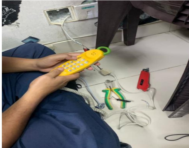
gambar 3. 23 pengecekan menggunakan telephone tester
