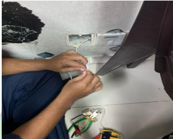
gambar 3. 21 pengikisan kabel yang terkena korosi
