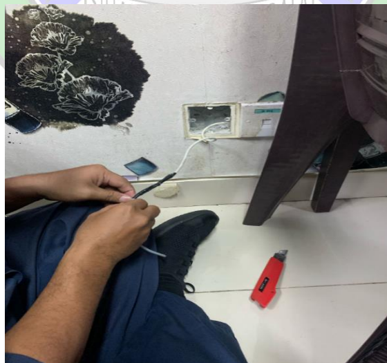
gambar 3. 20 Pembukaan lapisan kabel
