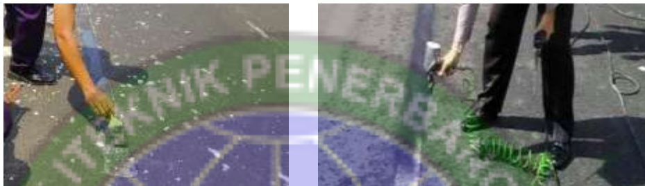
Gambar 3. 4 Cara penghapusan marka dengan sistem tradisional
