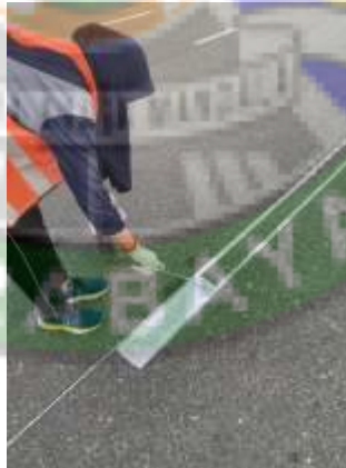
Gambar 4. 16 Proses Pengecatan
