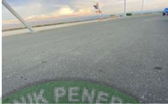
Gambar 4. 17 Service Road Sebelum Pengecatan
