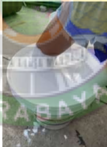
Gambar 4. 14 Pencampuran cat dengan air
