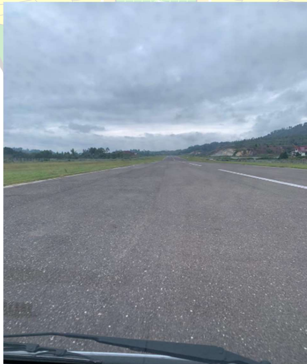
Lampiran 5 Dokumentasi Inspeksi harian Bandar Udara Toraja
