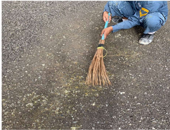
Gambar 4.11 Pembersihan area yang mau dicat
