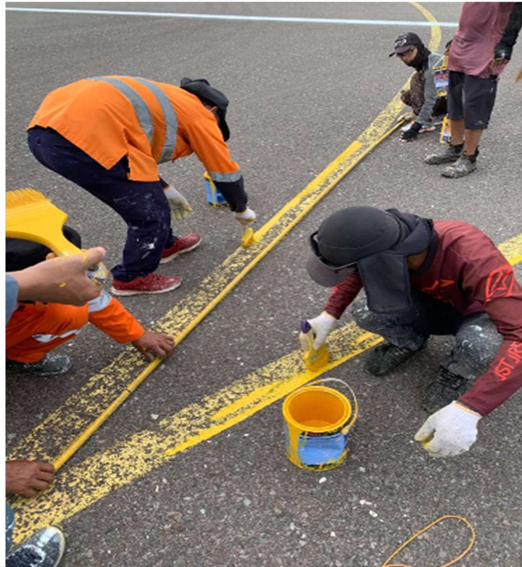
Lampiran 4 Metode pengecatan dengan meggunakan pipa
