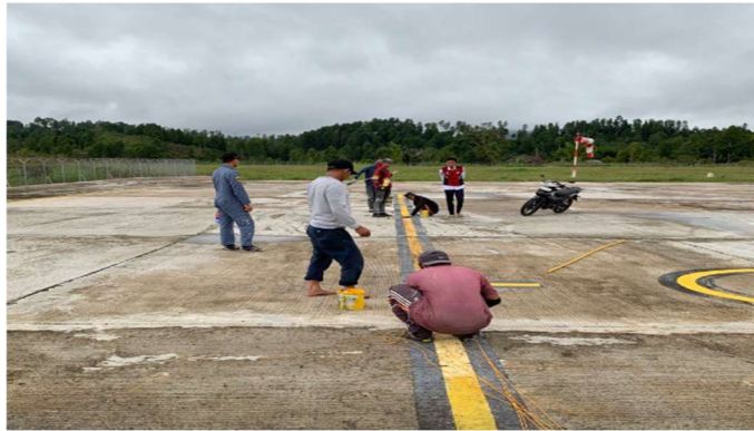
Gambar 4.13 Pengecatan pada marka Apron
