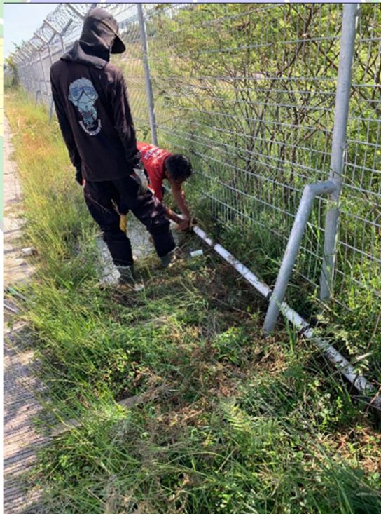
Lampiran 3 Perbaikan pipa pada area jalan inspeksi
