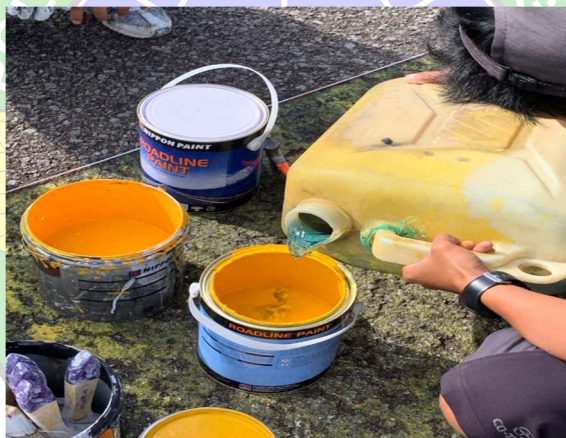
Gambar 4.10 Pencampuran cat dengan bahan pencair
