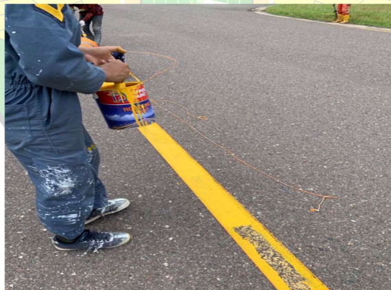
Gambar 4.12 Pengecatan pada marka taxiway
