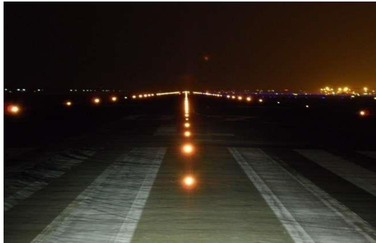
Gambar 2. 9 Runway Centerline Light Sumber: Penulis
