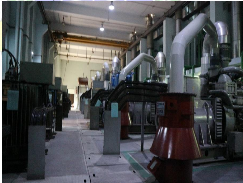
Gambar 2. 27 Genset Stand by Gedung MPS 1 (Lama) Sumber: Penulis
