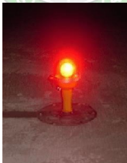
Gambar 2. 11 Stopway Light Sumber: Penulis
