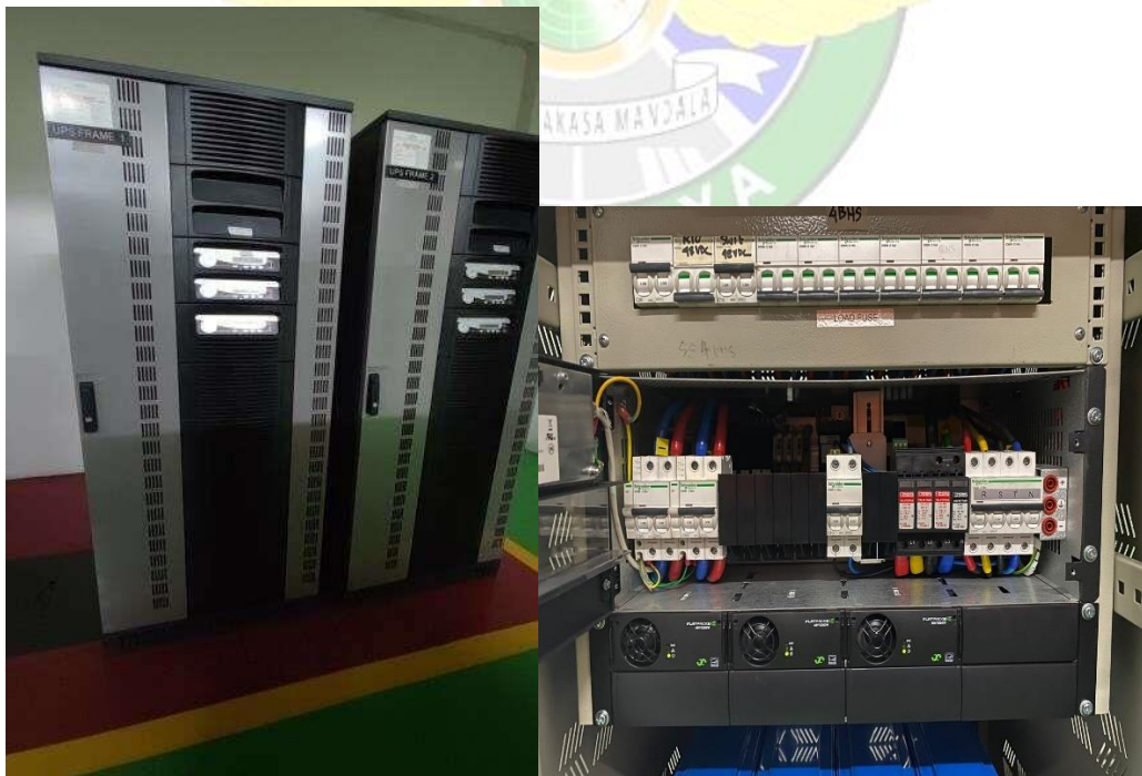
Gambar 2. 39 UPS dan Converter Sumber: Penulis
