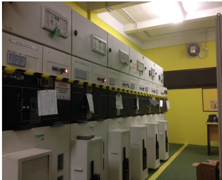
Gambar 2. 37 Panel Tegangan Menengah di Gardu NP52 Sumber: Penulis
