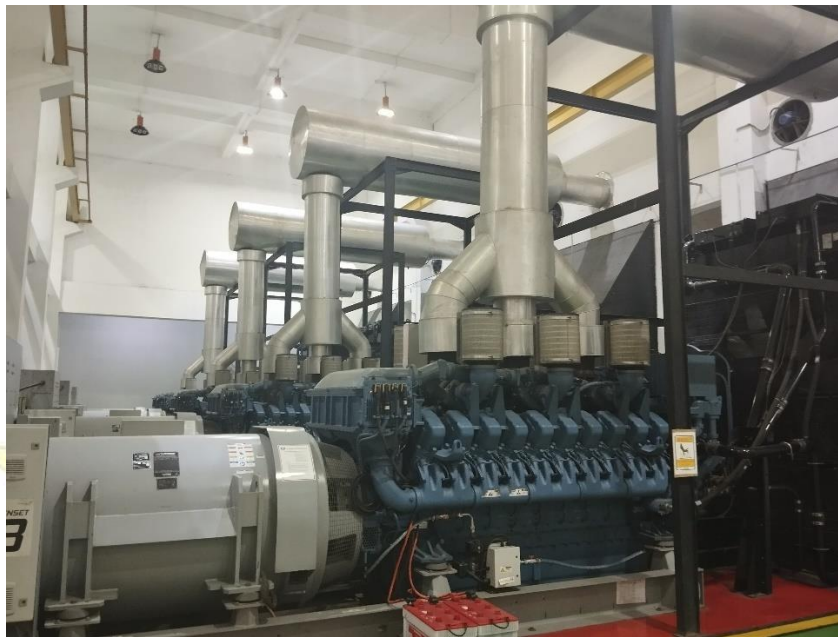
Gambar 2. 30 Genset Gedung MPS 3 Sumber: Penulis
