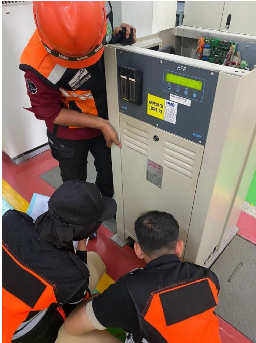
Pengukuran arus pada CCR
