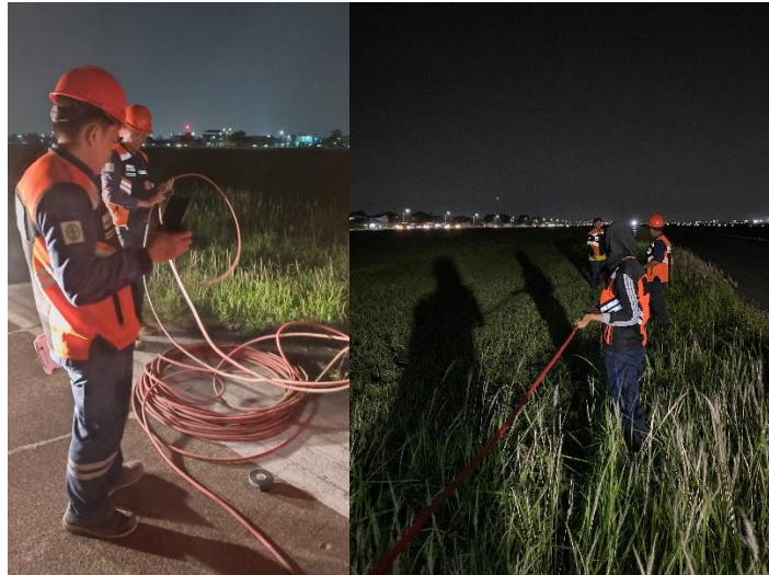
Gambar 4. 3 Pergelaran Kabel
