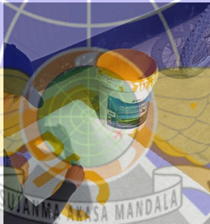
Gambar 4.28 Pengecatan Marka
