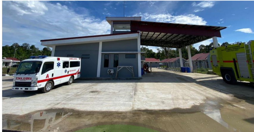
Gambar 4. 8 Gedung Fire Station Mentawai (Sumber: Olahan Penulis, Tahun 2023)
