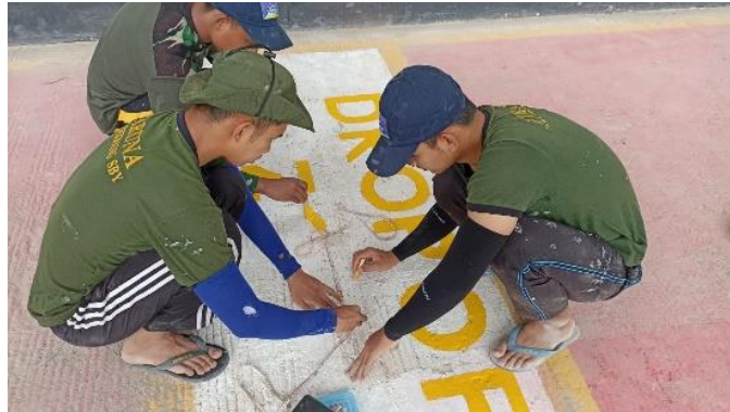
Gambar 4.27 Pembuatan Tulisan Marka
