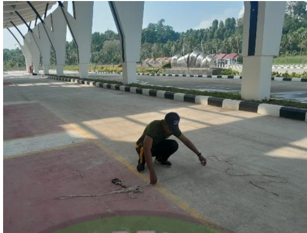
Gambar 4.25 Pembuatan Sketsa Marka
