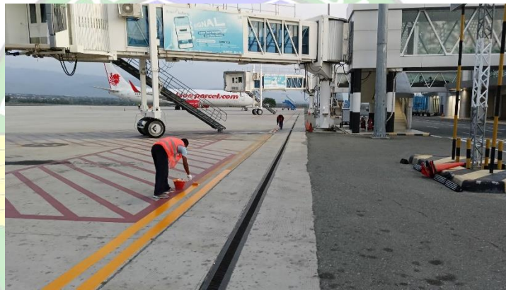
Gambar 4. 17 Pengecatan Marka Apron Line Edge
