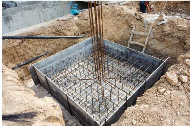
Gambar 3 1 Pondasi Telapak
