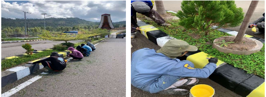
Gambar 4. 17 proses pengecatan kanstin
