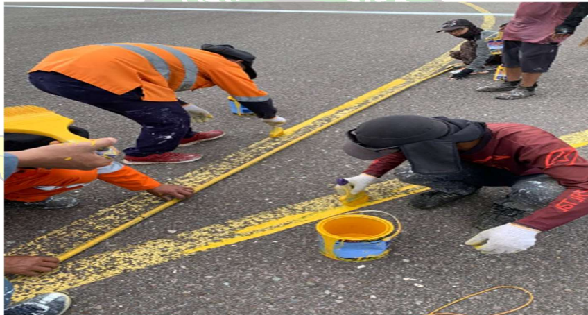
Lampiran 10 Metode pengecatan menggunakan pipa
