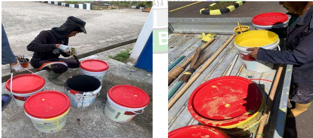
Gambar 4. 16 proses pencampuran cat menggunakan air
