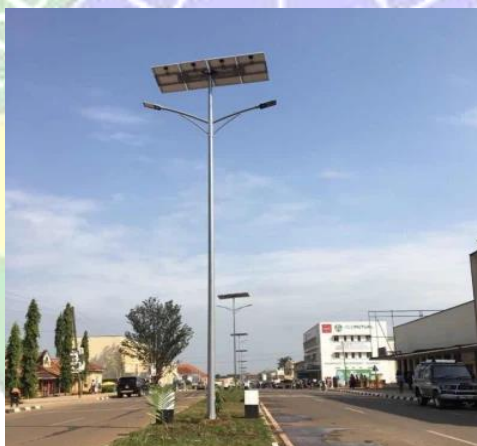
Gambar 3. 1 Penerangan Jalan Umum Berbasis Solar Cell
