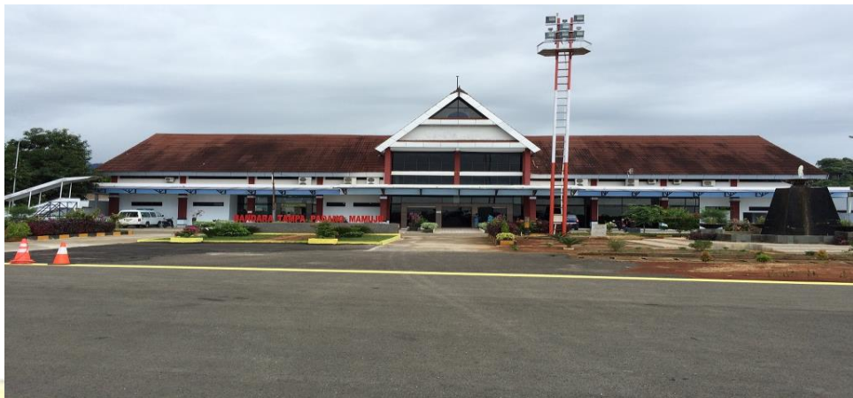
Gambar 2. 8 Gedung Terminal Bandar Udara Tampo Padang Mamuju
