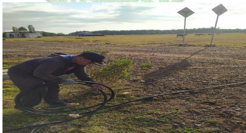
Pemasangan Kabel Jaringan Distribusi
