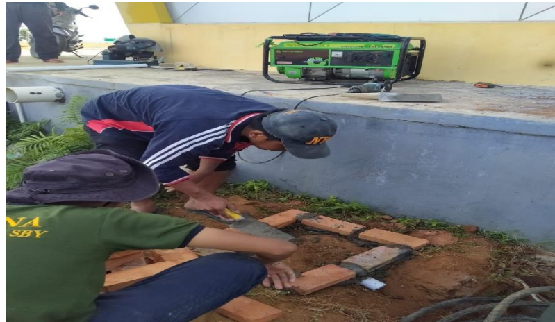
Pembuatan Bak Grounding
