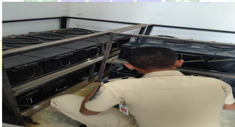
Pembersihan Ruang UPS
