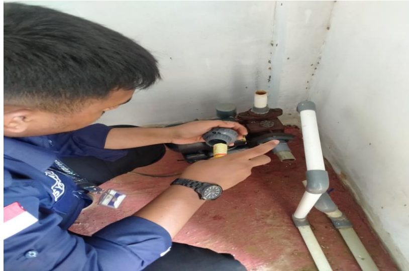
Perbaikan Pompa Air Power House
