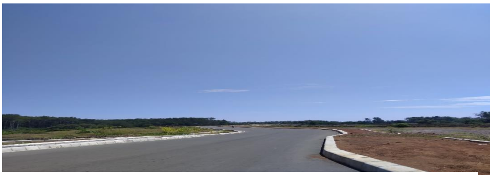
Gambar 4. 1 Kondisi jalan sebenarnya
