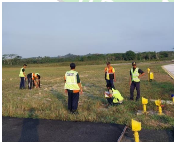
Pengukuran jarak antar lampu di runway
