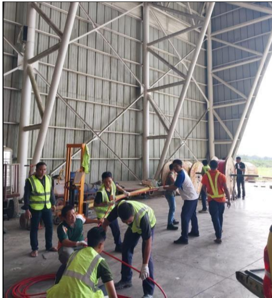
Penarikan Kabel AFL
