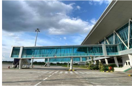
Gambar 2. 5 Fixed Bridge Sumber : UPBU A.P.T. Pranoto Samarinda
