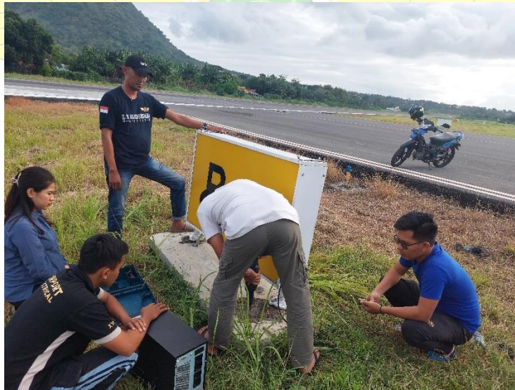
Perbaikan Lampu TGS
