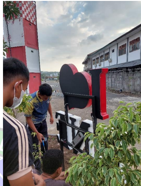
Pemasangan Kabel untuk Lampu Hias
