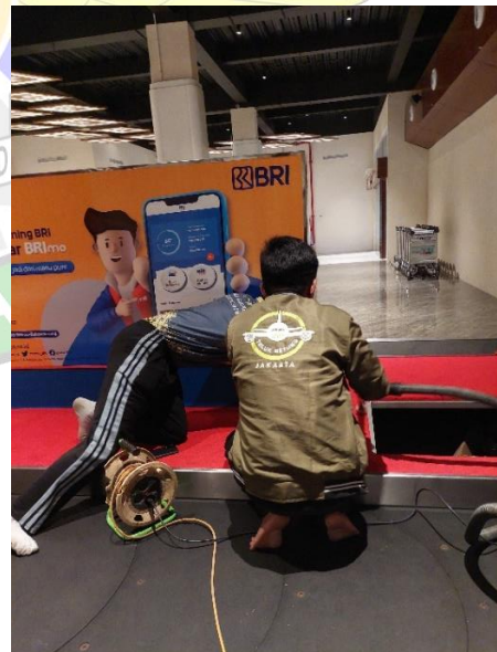
Pemasangan Papan Iklan
