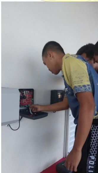
Perbaikan Rolling Door
